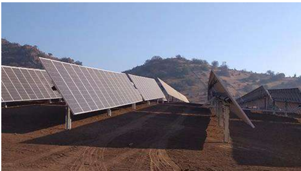
Figura 32. Sistema de hincado directo al terreno de la estructura solar.
