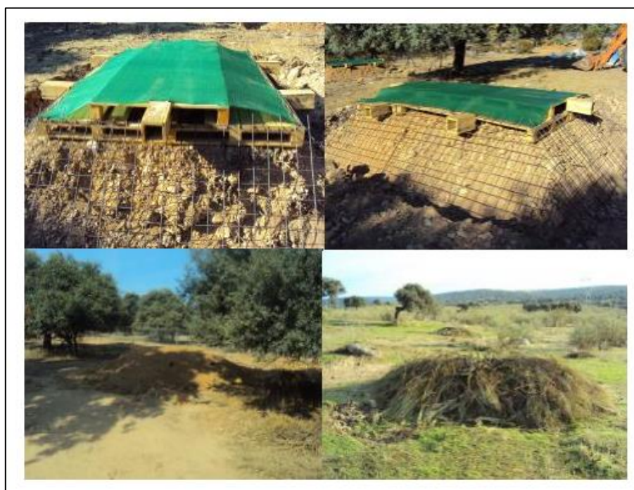
Ilustración 124. Fase de construcción de un majano de palets de madera
