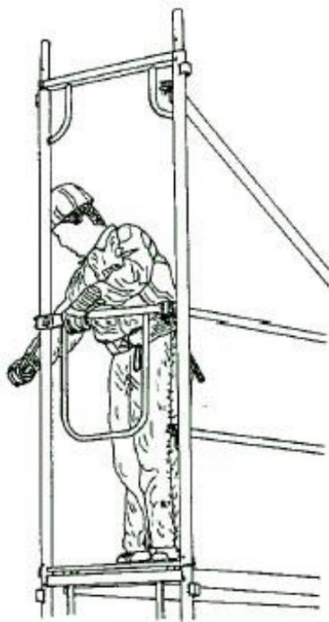
Colocar en la parte superior final del andamio los montantes de la barandilla, en todo el perímetro de las plataformas de trabajo y colocar el encadenado de las barandillas en la coronación del andamio: pasamanos, barras intermedias y rodapiés.
