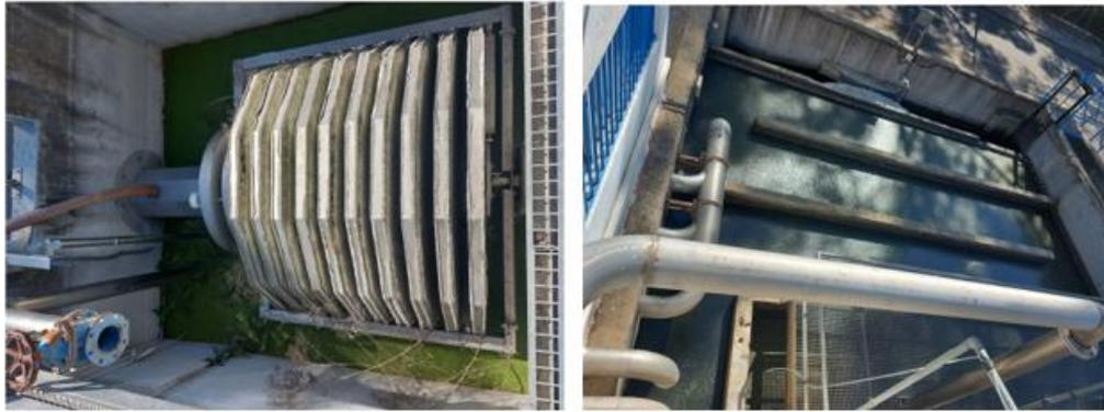
Figura 2.3. Instalación de filtración (a sustituir) izquierda y Laberinto de cloración derecha
