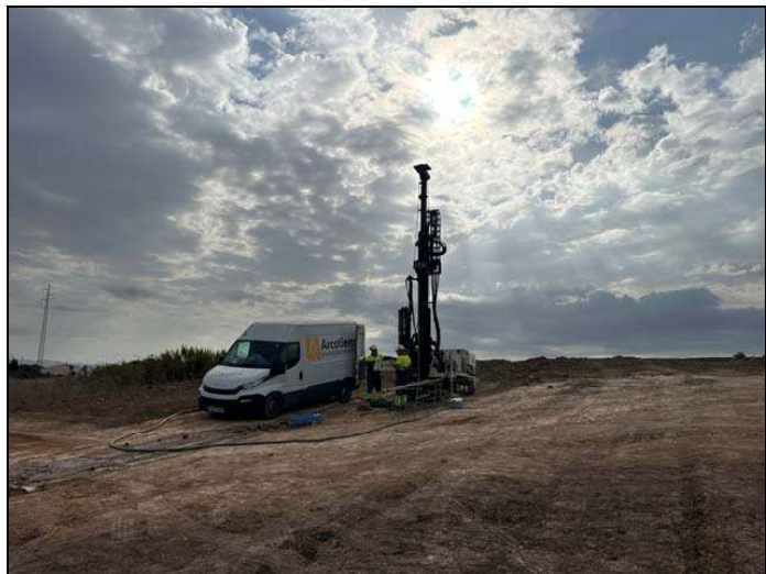
Fotografía 5.- Ejecución de sondeos a rotación con recuperación de testigo.
