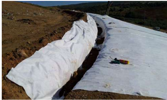
Figura 1. Instalación del geotextil
