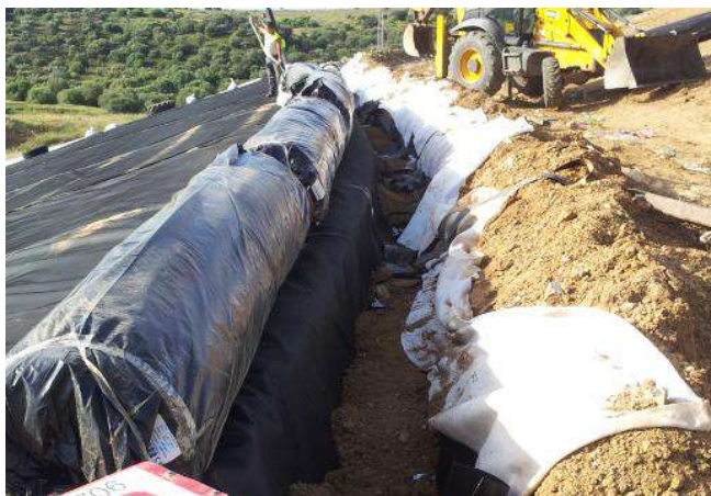
Figura 1: Ejemplos de anclaje de lámina mediante zanja
