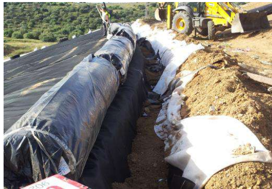
Figura 2. Instalación de la lámina de PEAD
