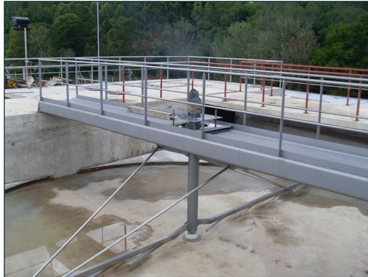
Figura 4-9. Sistema de separación de arenas.
