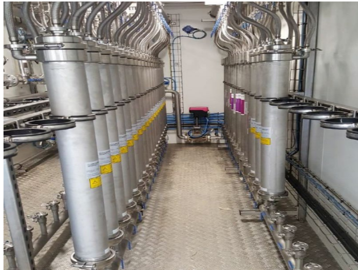
Figura 4-22. Upgrading de biogás por membranas (Propio).
