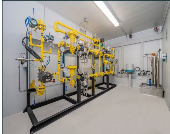
Figura 4-23. Módulo de inyección a red. Fuente: Virtus.
