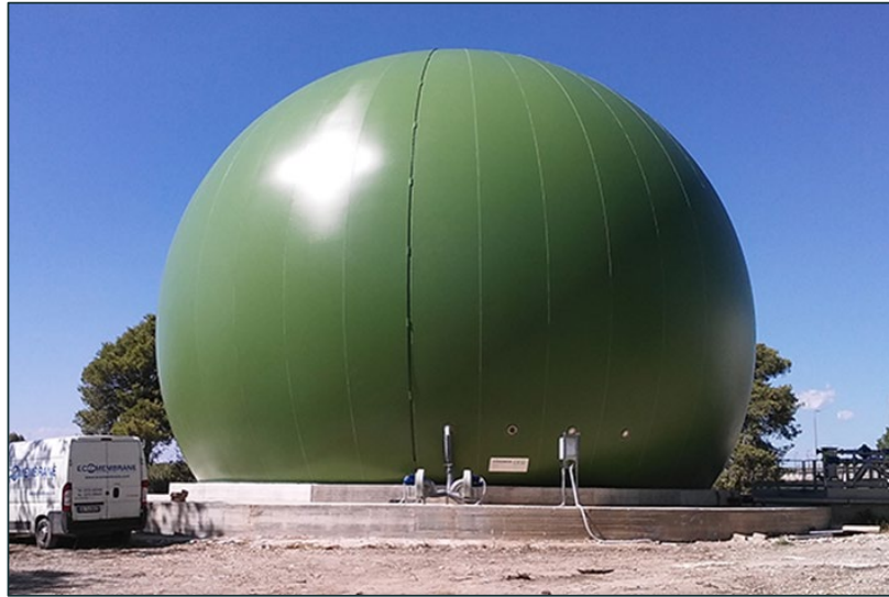
Figura 4-15. Membrana de almacenamiento de biogás.
