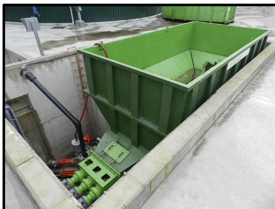
Figura 5-3. Tolva de recepción con tornillos de extracción.
