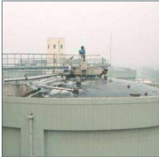
Figura 4-13. Sistema de agitación SCABA. Fuente: Virtus.
