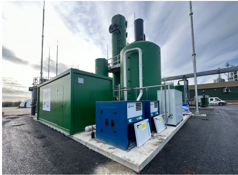
Ilustración 4-199. Instalación de desulfuración (Fuente: Virtus)
