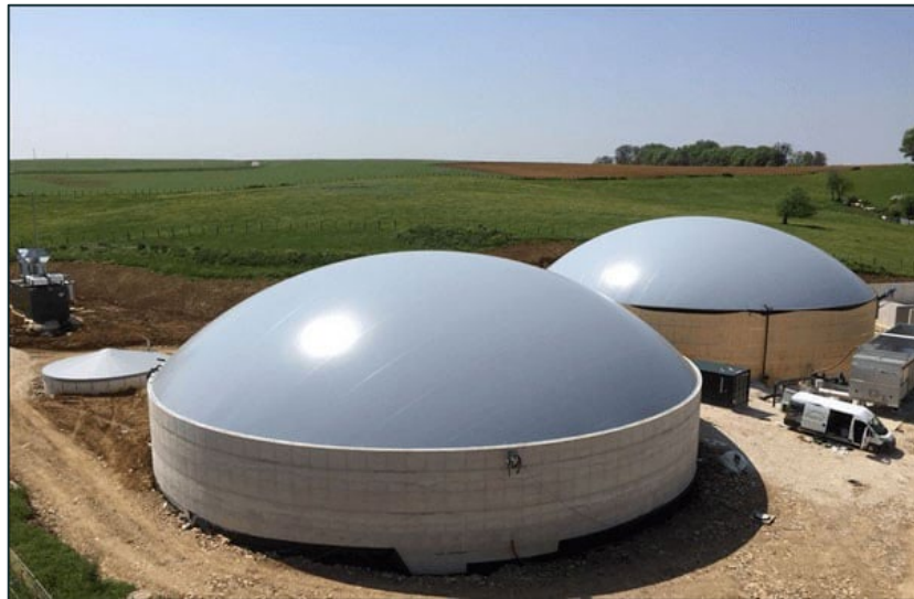
Figura 4-14. Post-digestores de hormigón.
