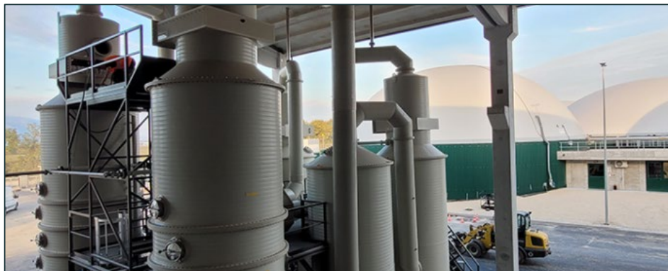
Figura 4-27. Sistema de recuperación de nitrógeno.
