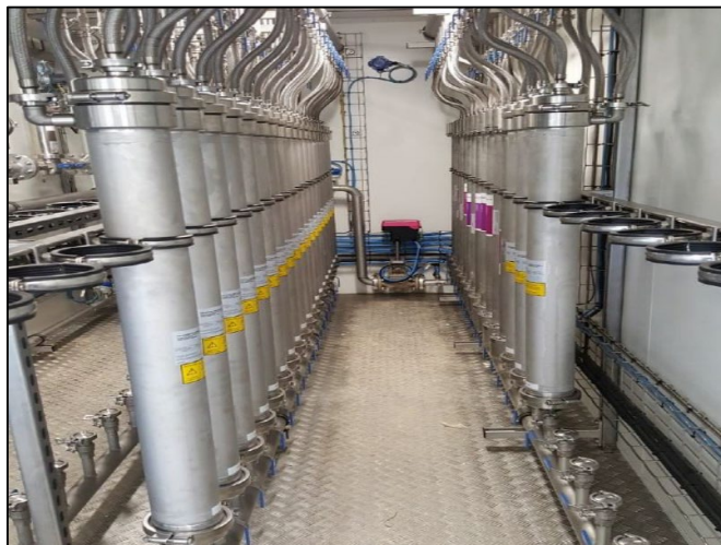
Figura 5-22. Upgrading de biogás por membranas. Fuente: Propio.
