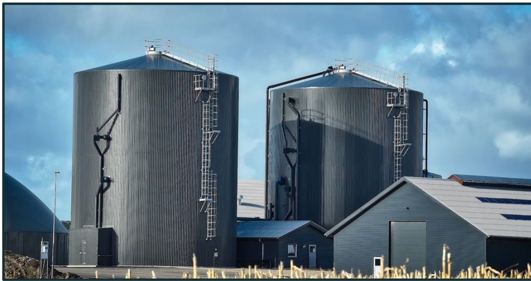
Figura 4-11. Digestor anaerobio.
