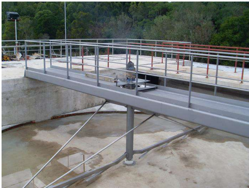
Sistema de separación de arenas
