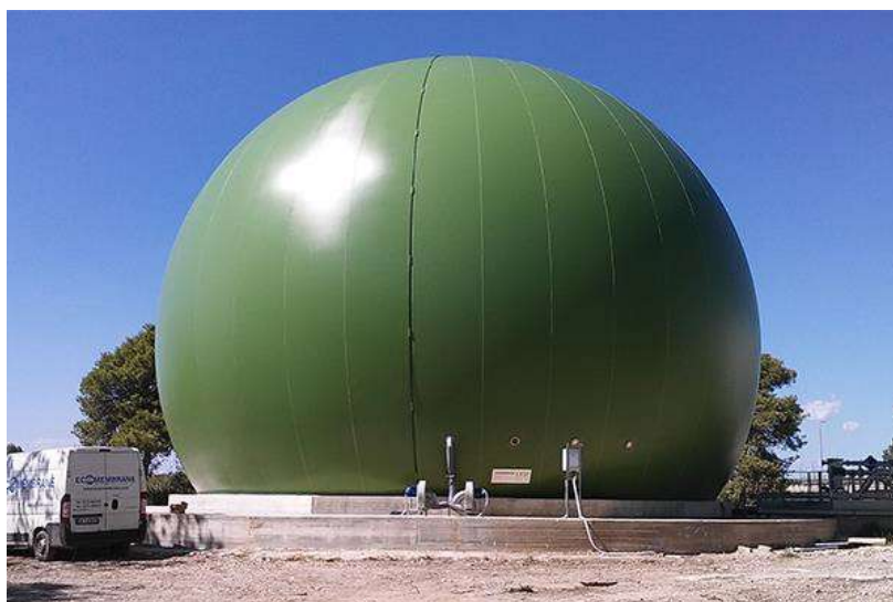
Membrana de almacenamiento de biogás
