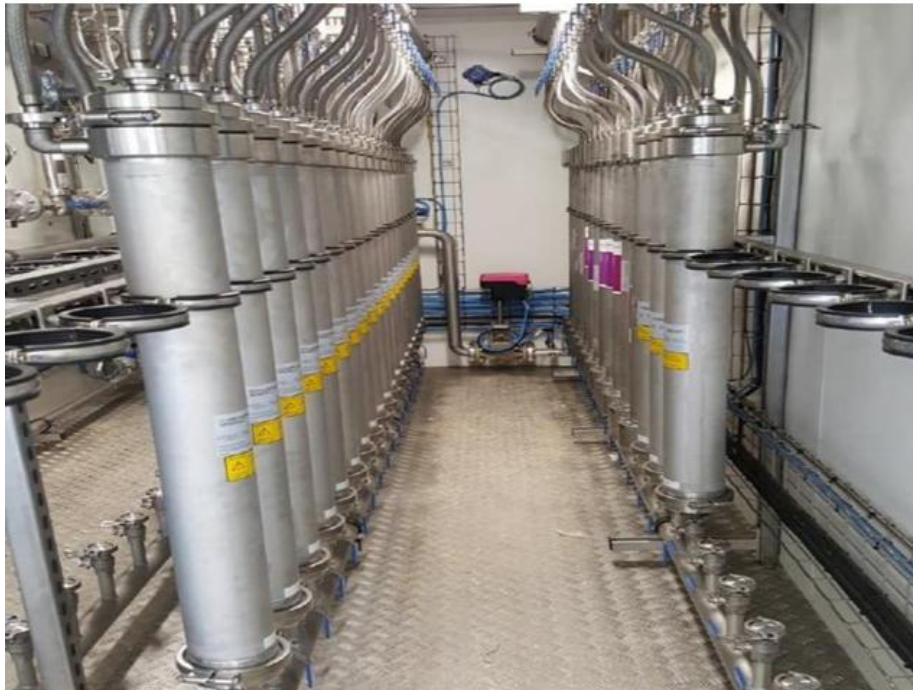
Figura 22. Upgrading de biogás por membranas.
