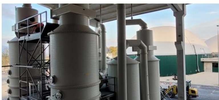
Figura 27. Sistema de recuperación de nitrógeno.
