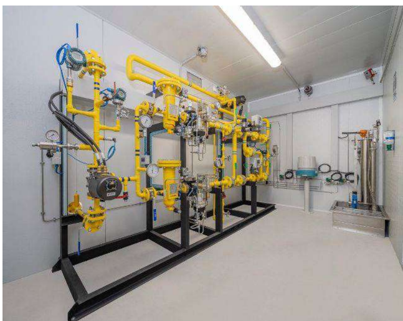
Módulo de inyección a red (Propio)
