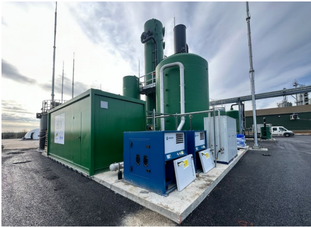
Figura 6-17. Desulfuración química con recuperación de reactivo.
