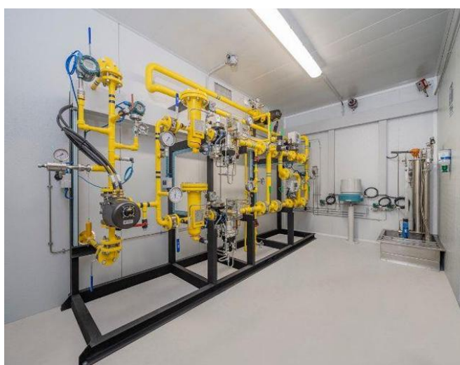
Figura 23. Módulo de inyección a red.
