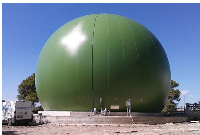
Figura 6-14. Membrana de almacenamiento de biogás.
