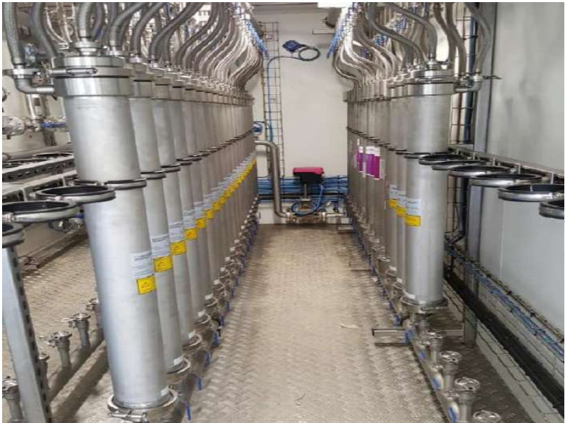
Upgrading de biogás por membranas (Propio)
