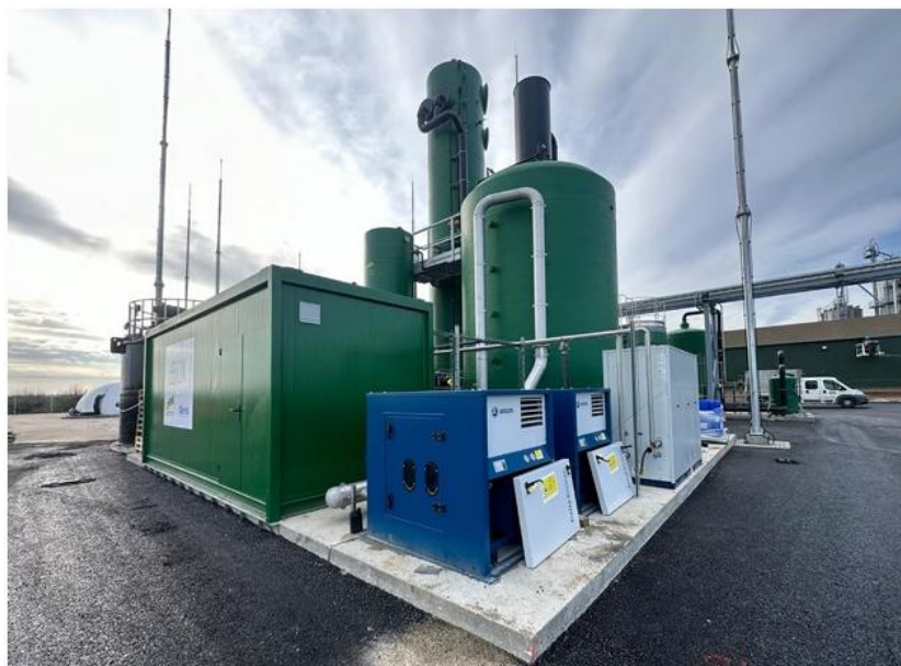
Figura 19. Instalación de desulfuración.
