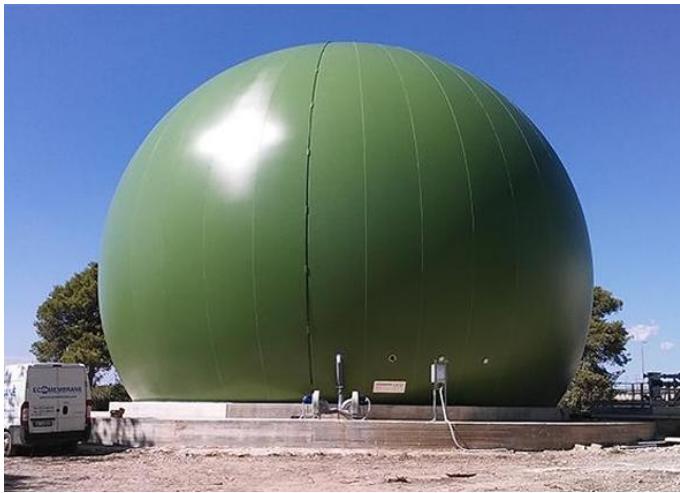
Figura 15. Membrana de almacenamiento de biogás.
