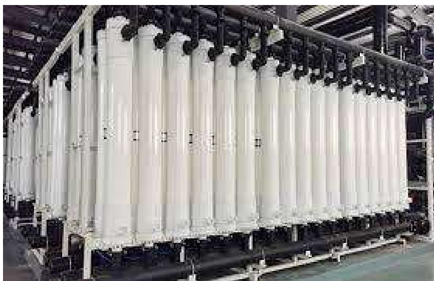
Instalación de ultrafiltración.
