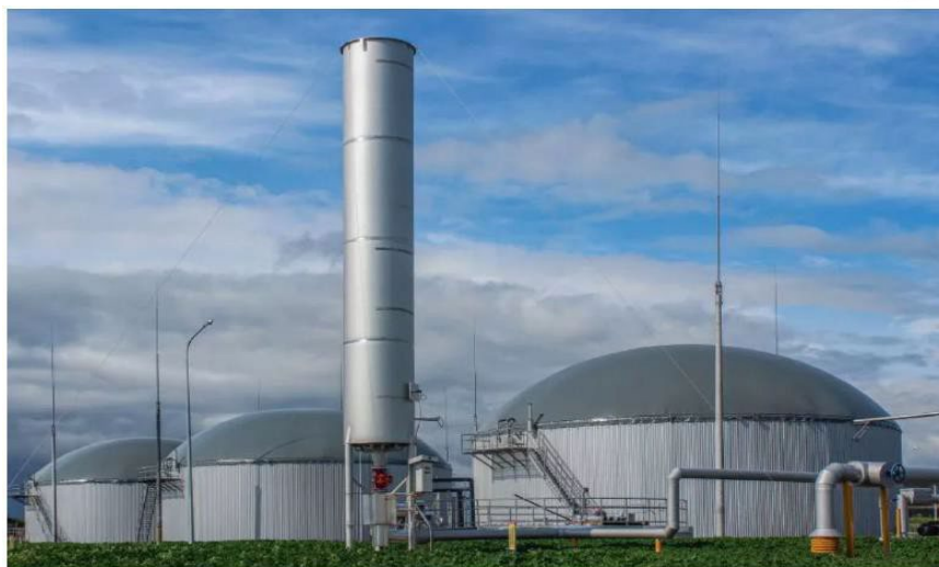
Figura 6-16. Antorcha de seguridad.
