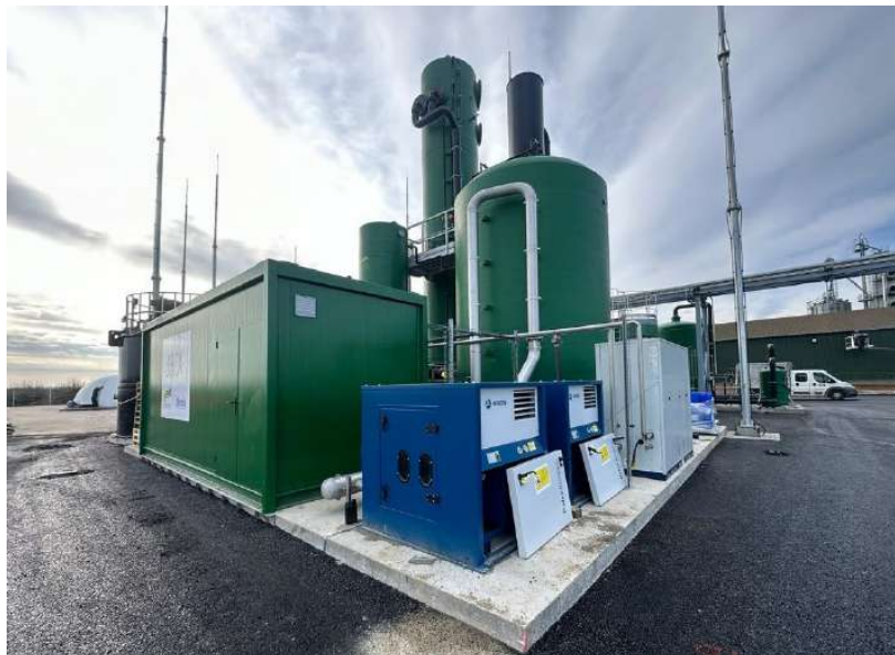
Instalación de desulfuración
