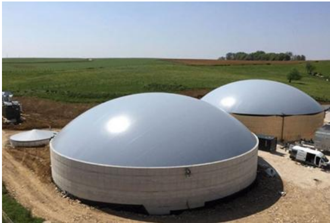
Figura 14. Post-digestores de hormigón.
