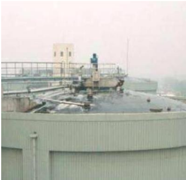
Figura 13. Sistema de agitación SCABA.
