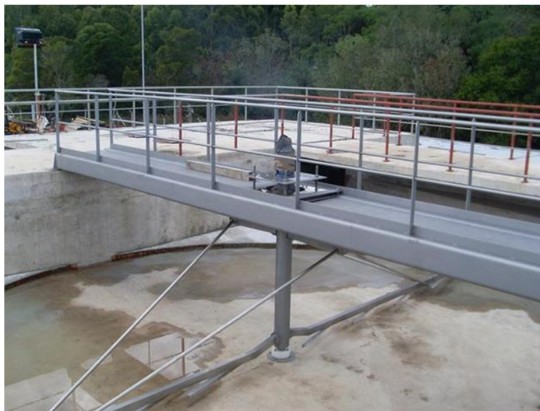
Figura 9. Sistema de separación de arenas.
