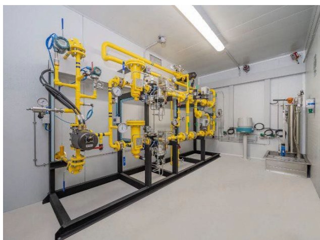
Figura 6-22. Módulo de inyección a red.
