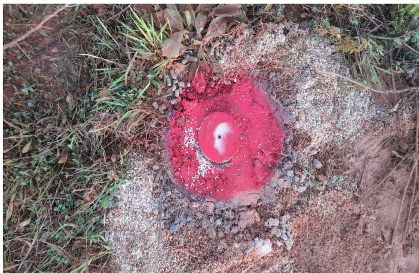
Instalación piezómetro P2.
