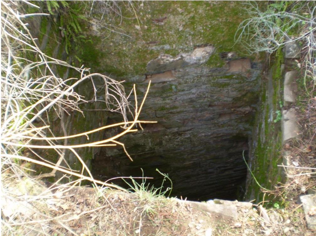
*Ilustración 15. Pozo revestido de 2 x 1,5 metros de sección en el indicio La onza (Foto F. Palero).*
