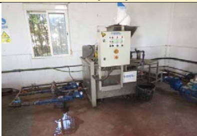
Equipo de preparacion de poli y bombas dosificadoras
