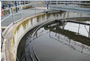
Detalle vertedero decantación secundaria
