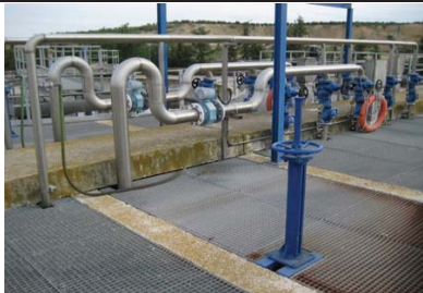
detalle bombes de recirculación líneas 1 y 2
