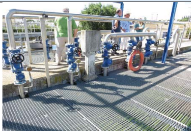
Bombeo de recirculación y purga de fangos
