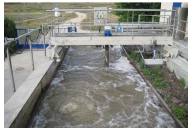
Detalle desarenado
