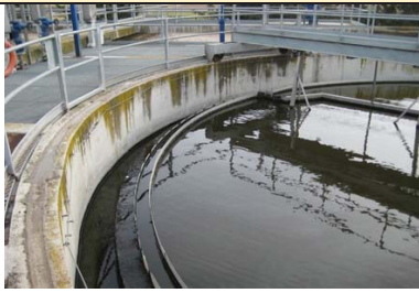
Detalle vertedero decantación secundaria
