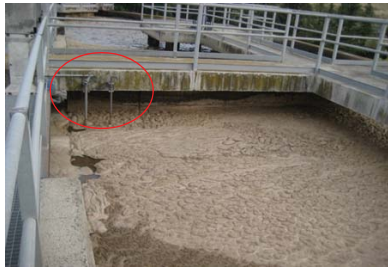
Detalle situación de medidores de oxígeno y redox
