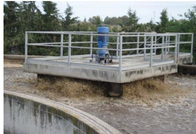
Detalle turbina de aireación
