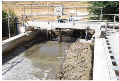
Detalle desarenado
