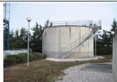
Espesador por gravedad
