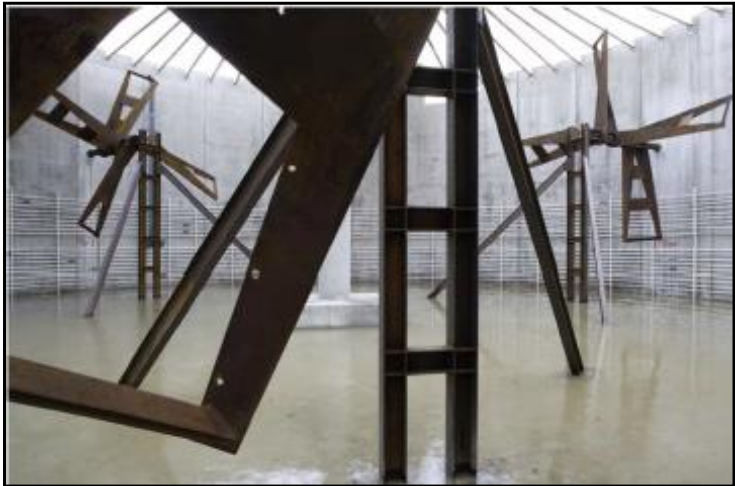
Ilustración 28. Ejemplo del sistema de mezcla interior de un digestor anaerobio.
