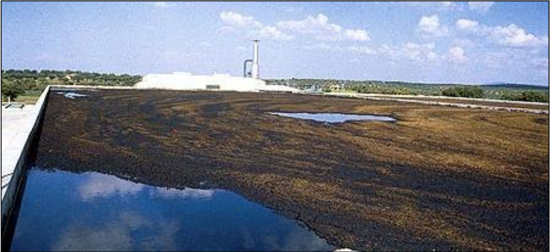
Ilustración 22. Ejemplo de costra en balsa de contención de alperujo.
