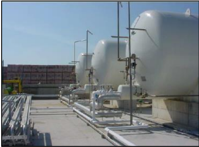
Figura 25: Ejemplo de tanque de almacenamiento de biometano licuado.
