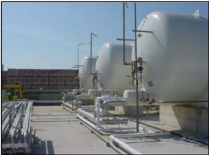
Ilustración 47. Ejemplo de tanque de almacenamiento de biometano licuado.
