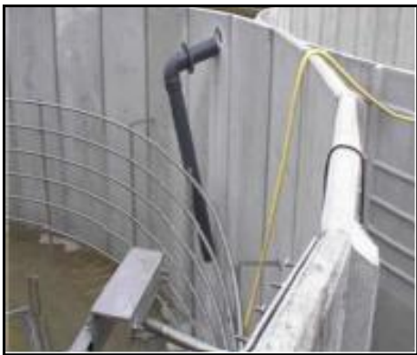
Ilustración 29. Ejemplo de sistema de calefacción de composite estratificado y de acero inoxidable.
