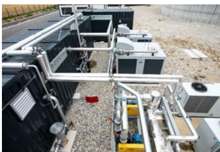
Ilustración 4. Sistema de secado (enfriadores, intercambiador de tubos) y compresión.
