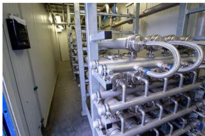
Ilustración 19. Membranas interiores para depuración del gas en unidad de upgrading.
