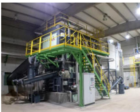
Ilustración 34. Ejemplo caldera biomasa.
