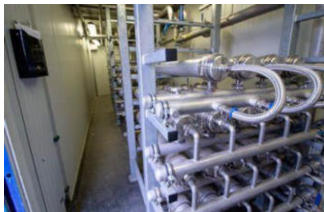
Ilustración 31. Membranas interiores para depuración del gas en unidad de upgrading.
