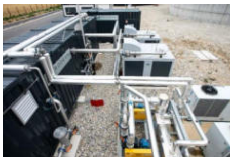
Ilustración 16. Sistema de secado (enfriadores, intercambiador de tubos) y compresión.
