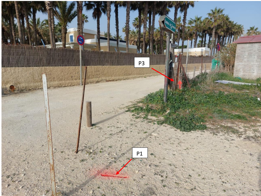
Imagen Nº3 – Frente de fachada y ubicación de armario contador (P3)
