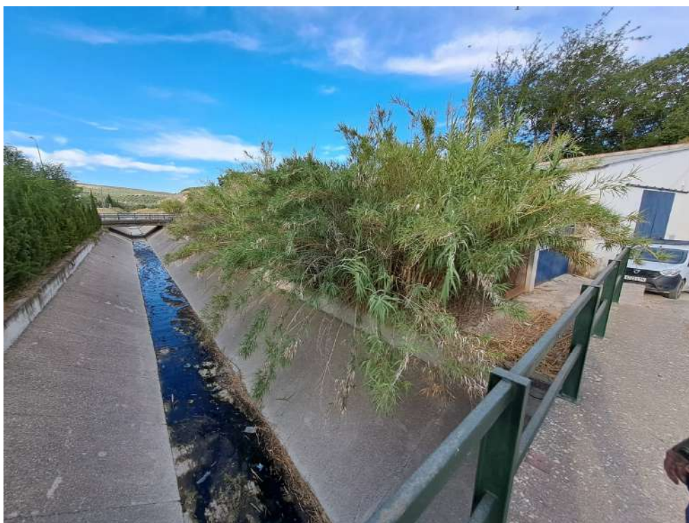
Foto: 2 tubos de bombeo discurrirán grapeados por la viga del tablero del puente del Arroyo de “Las Canteras”, por el puente que se aprecia en la fotografía en primer plano.
