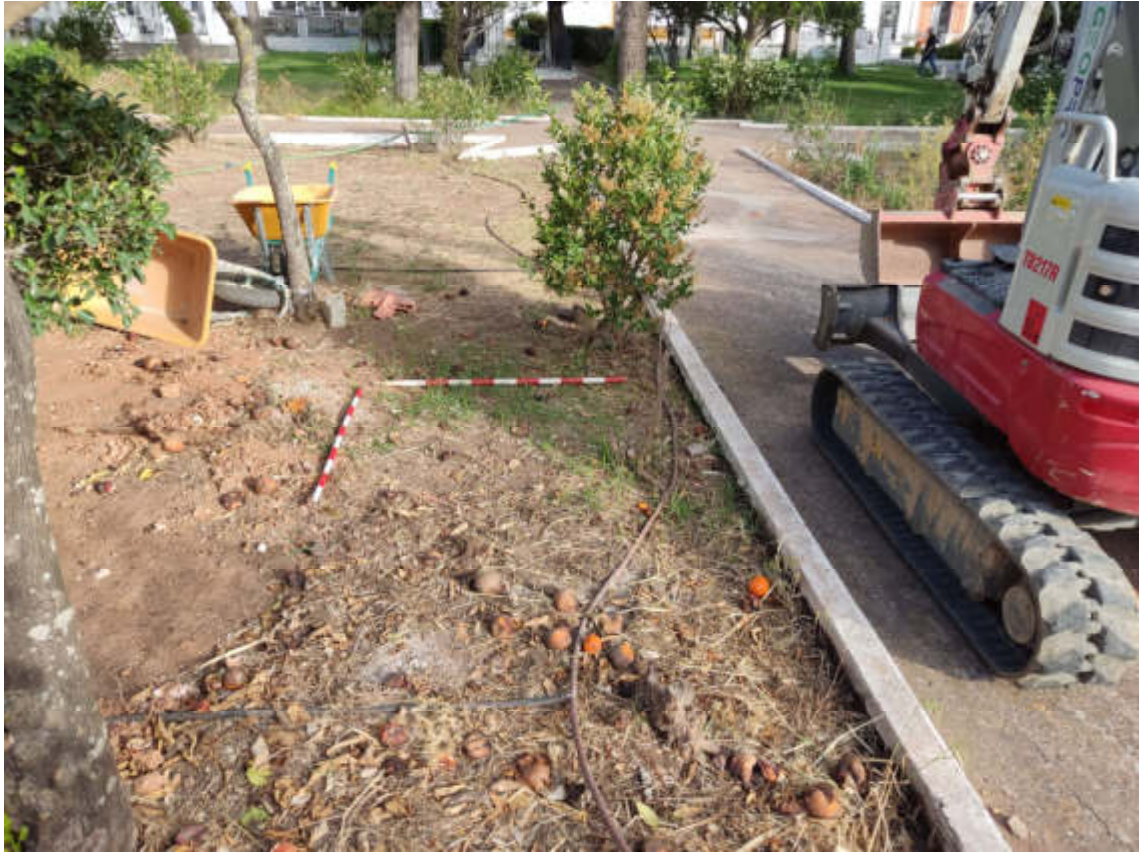
Foto. Inicio del sondeo 4.
