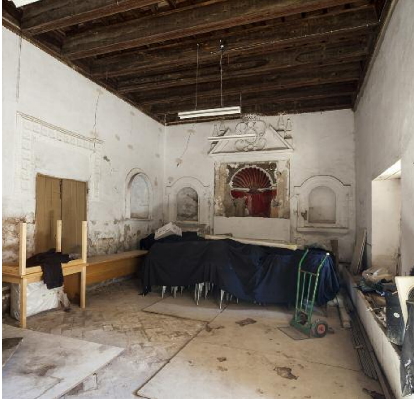
UNO DE LOS APOSENTOS PRINCIPALES DEL PALACIO SIRVIÓ AL CONVENTO DE SALA CAPITULAR. TIENE UN SUELO DE LADRILLOS A LA PALMA, UN TECHO DE GRANDES VIGAS CON TABLAZÓN Y FRAGMENTOS DE YESERÍAS.
