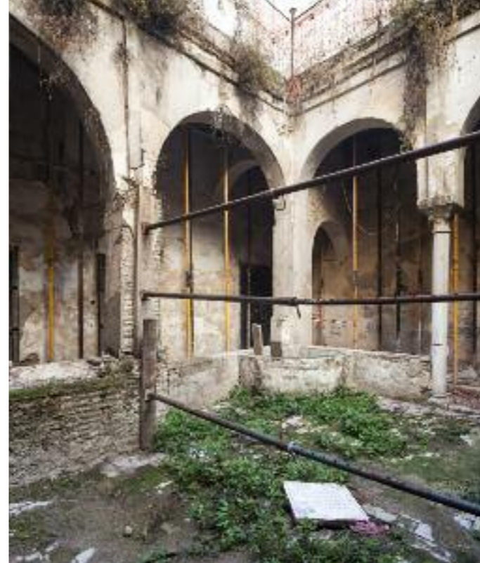
PATIO DEL LAVADERO
