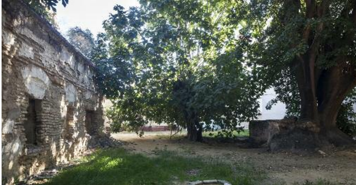
VISTA PARCIAL DEL SOLAR DEL JARDÍN O HUERTA, CON EL TRONCO DE UN OMBÚ JUNTO AL POZO Y HUELLAS DE LA NORIA.
