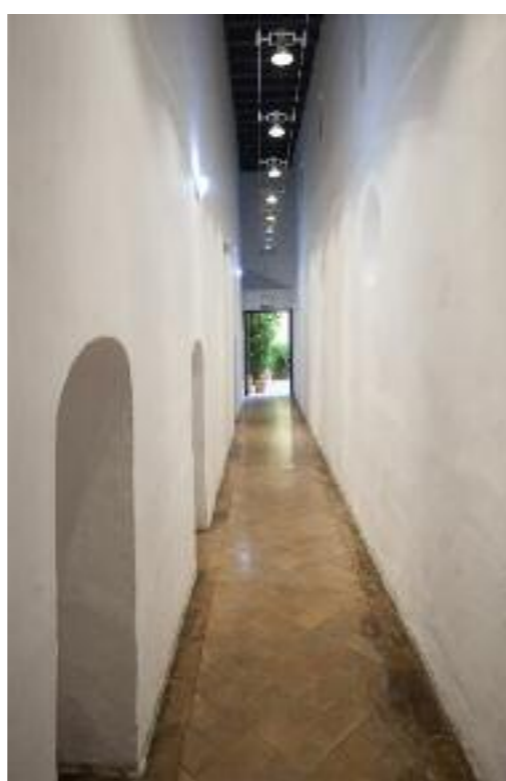
PASILLO DE LOS CONFESIONARIOS Y CONEXIÓN DEL CORO BAJO CON LA IGLESIA NUEVA.
