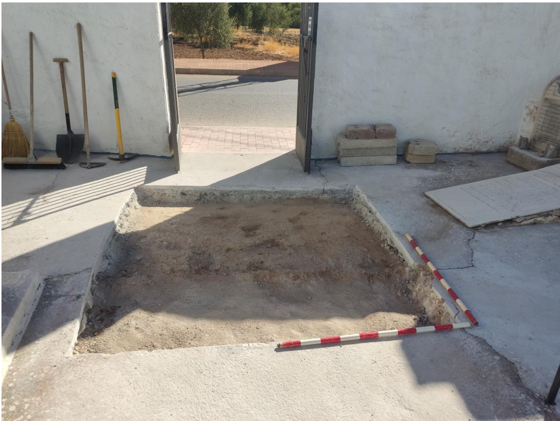
Foto. Sondeo 1, tras la retirada del pavimento de hormigón.
