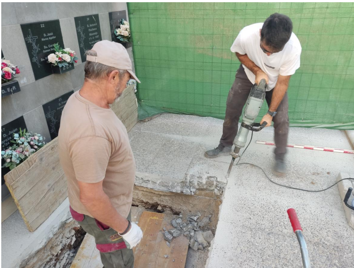
Foto. Detalle de la ampliación del sondeo 3.
