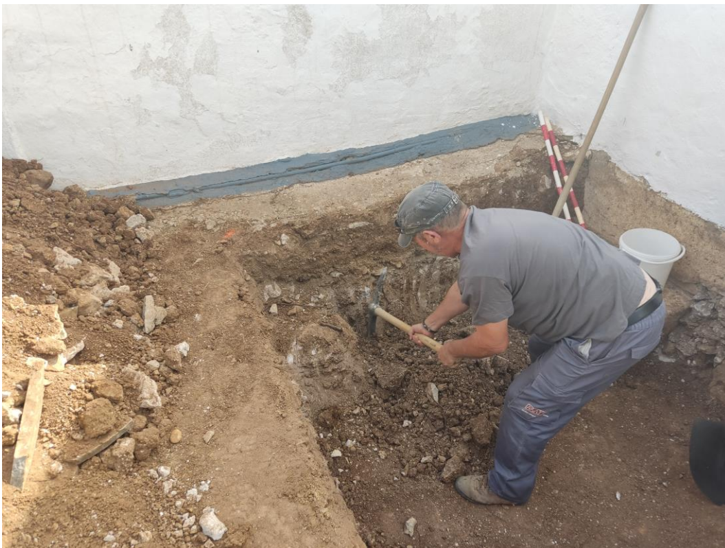
Foto. Detalle de los trabajos, retirada de tierra de manera manual.
