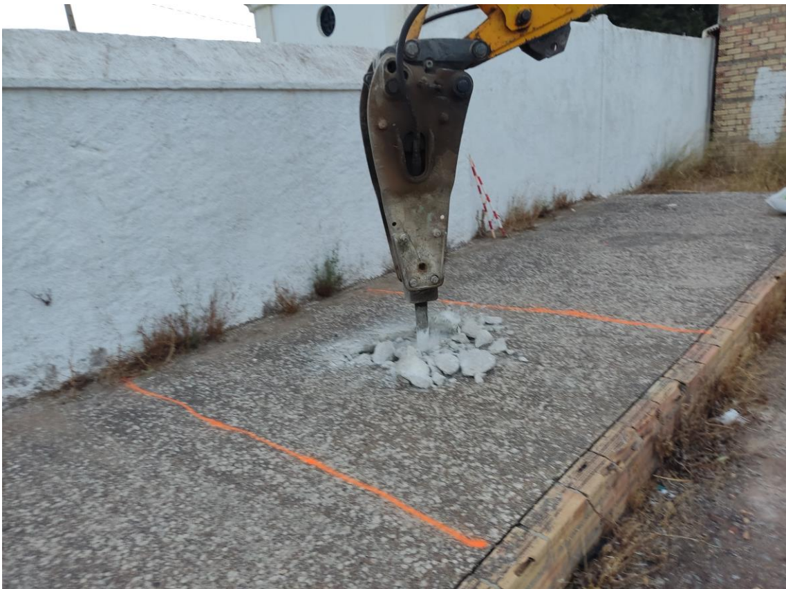
Foto. Detalle del picado de hormigón
