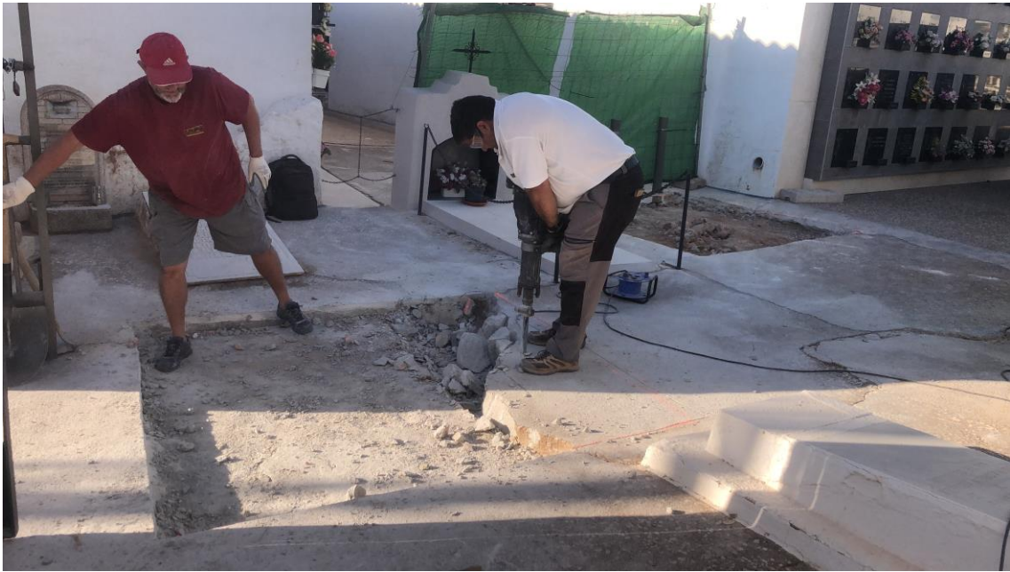
Foto. Picado del pavimento de hormigón.
