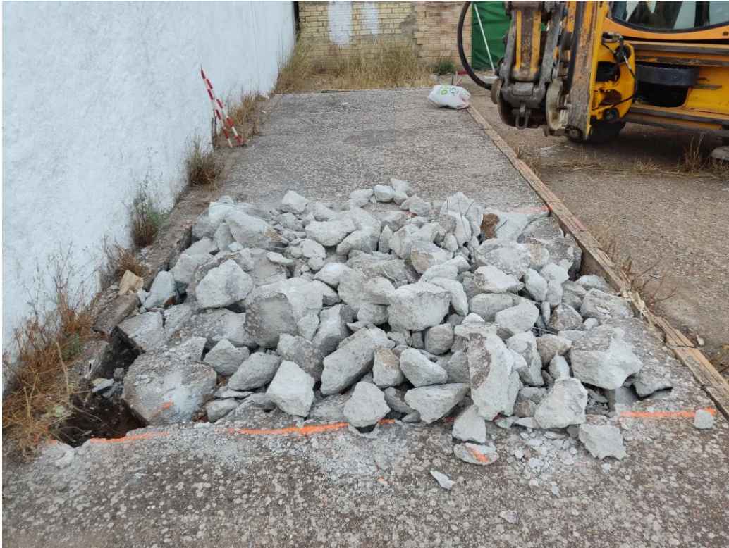
Foto. Detalle del picado de hormigón
