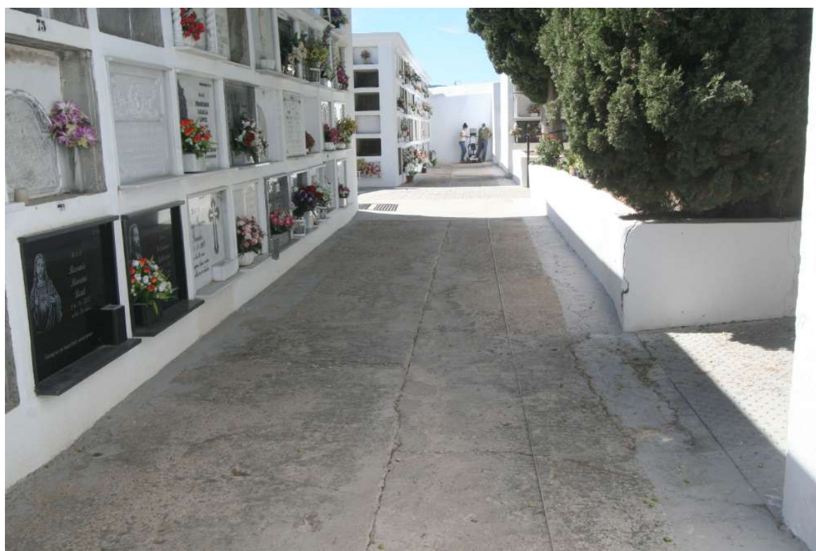
Fig. 23. Fotografía detalle de la calle correspondiente al Proyecto 07.
