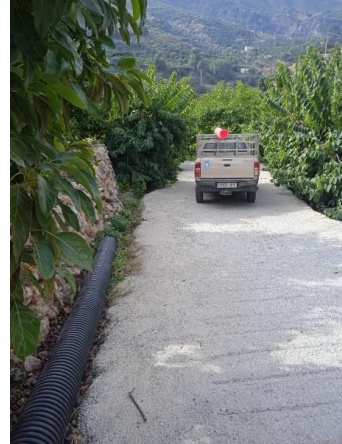
Colocación de tubos para el riego.
