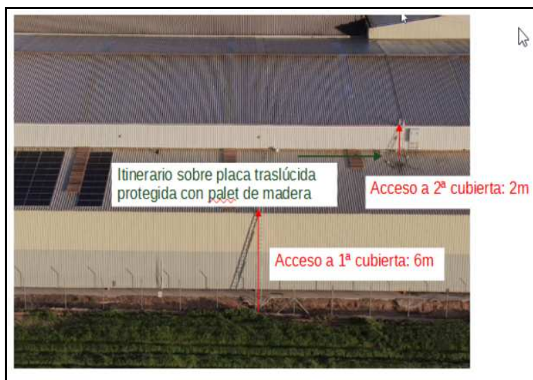
Fotografía n.º 2. Fotografía del accidente OT-13-23 .
