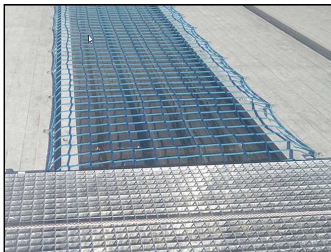
Fotografías n.º 4, 5 y 6. Medidas Preventivas: pasarelas (PARA NO PISAR EN) y redes y mallas electrosoldadas (PARA NO CAER DESDE) .
