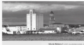
Silo de Mérida / FUENTE: GUERRA Y SUELL
