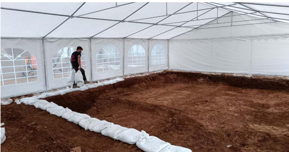
*Ilustración 10:* Adecuación de los espacios de protección interiores mediante sacos terreros.
