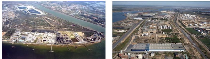
Ilustración 29: Imágenes Polo Químico (Izda.) y P. I. Nuevo Puerto (Dcha.)
