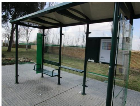
Ilustración 21: Parada accesible situada en el acceso al Hospital Infanta Elena de Huelva.
