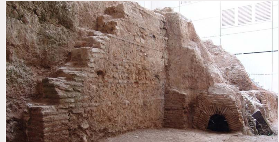
Horno de teja y ladrillo de La Cartuja. Muro de contención y boca de la cámara de combustión. S. XVI-XVII [Fotografía: Rafael Turatti Guerrero]
