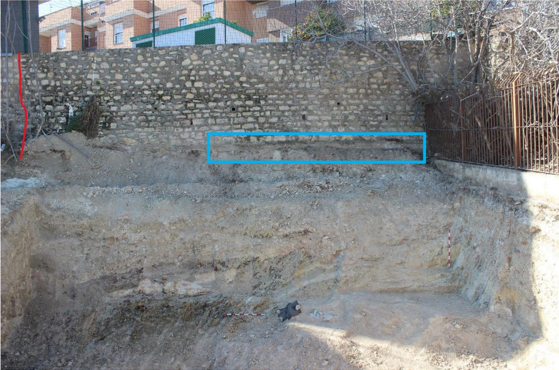
Fig. 33. Vista de la tapia occidental del cementerio en la esquina noroeste del mismo. En rojo cambio de mampostería que evidencia la reconstrucción. En azul zuncho de hormigón para cimentar la reconstrucción del muro.
