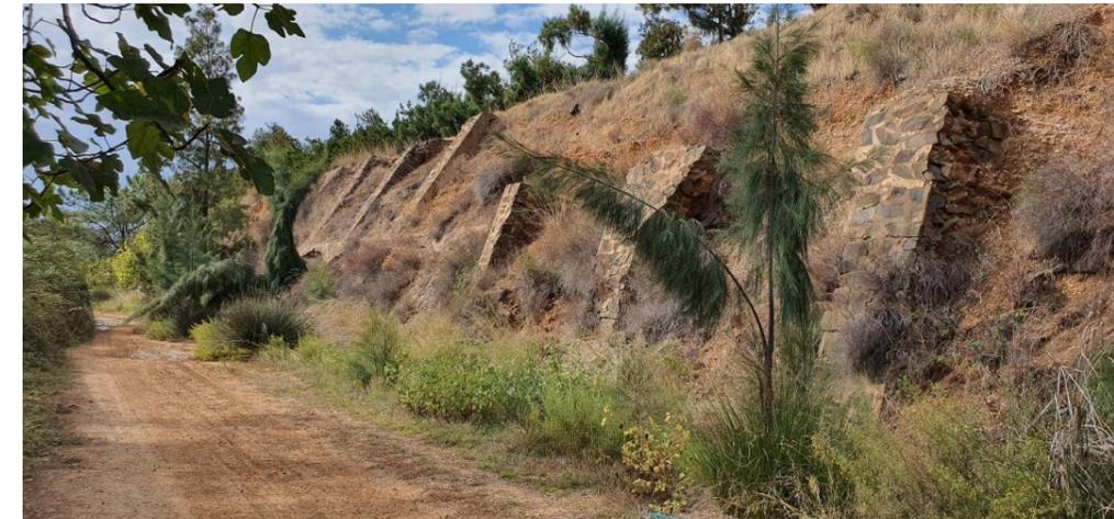
**Figura 3.1.7. Desprendimiento de taludes.**
