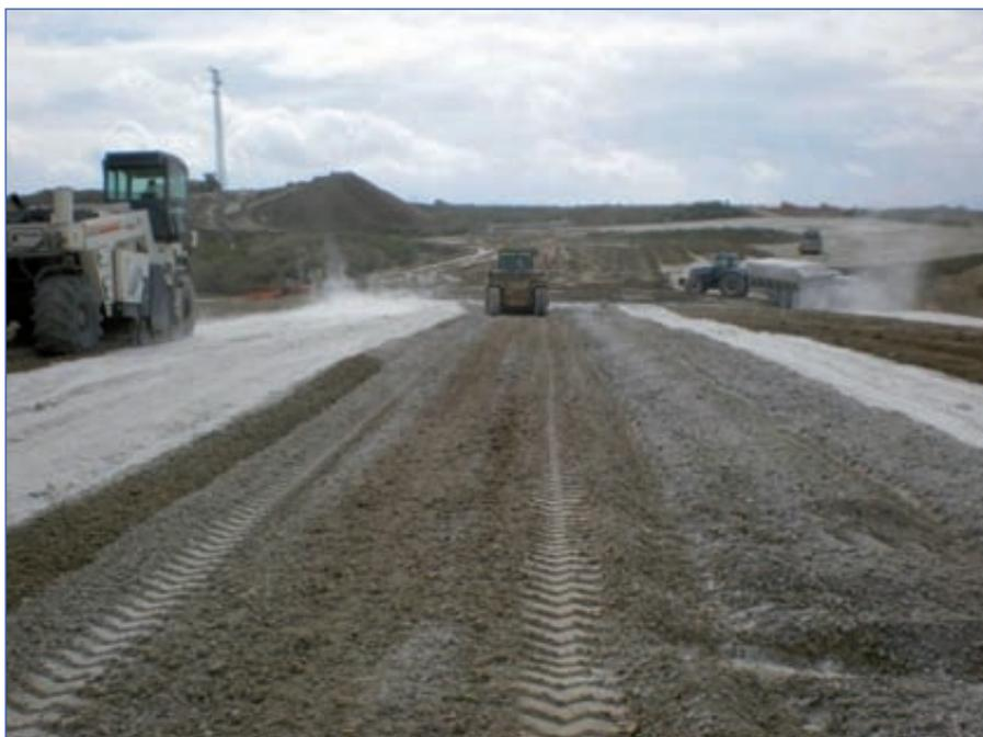
**Foto 14.** Estabilización de suelos con cal y cenizas.
