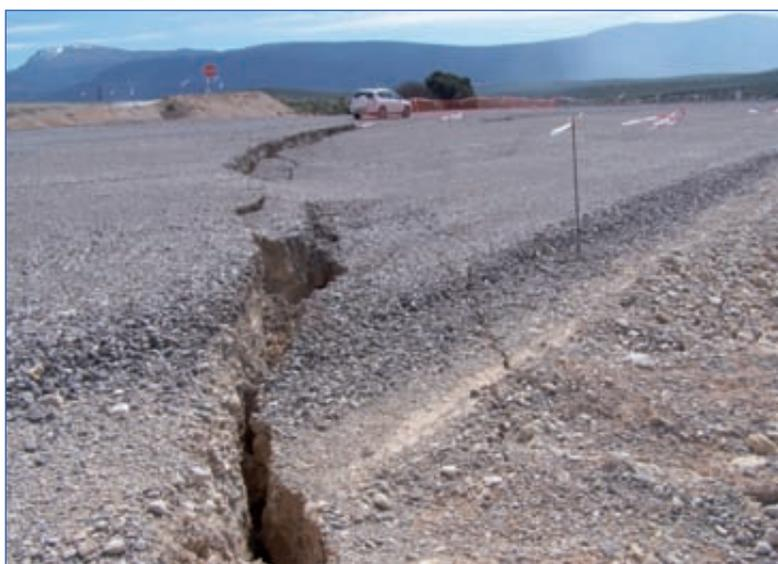
Foto 5. Deslizamiento de ladera en el apoyo del terraplén. Patología.
