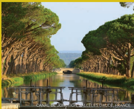
CANAL DE JONCTION, SALLES D'AUDE, FRANCE
