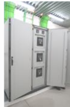
Detalle armario de interruptores de corte Trafos 1 y 2
