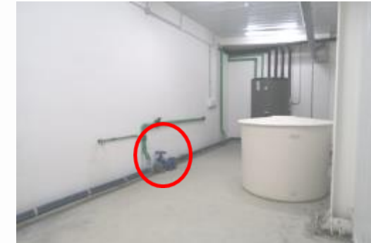
Cuarto interior nave de almacenes. Llave de corte general, depósito y termo ACS
