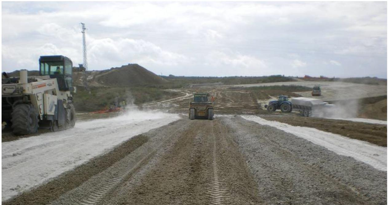
Estabilización con cal y cenizas
