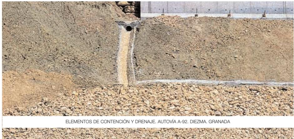
El agua fue el principal agente causante del deslizamiento y procedía de las calizas existentes por encima del mismo. El terreno deslizado está compuesto por arcillas margosas que son las que recibieron el empuje de las aguas y por su escasa cohesión, sufrieron un movimiento situado a una profundidad entre los 15 y 30 metros.
