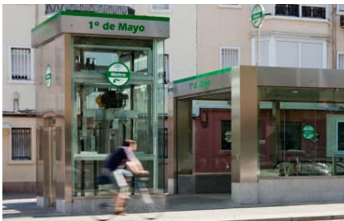
Carril-bici junto a la estación de Metro de 1º de Mayo.
