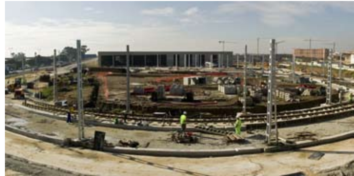
Construcción de instalaciones y edificios de Cocheras.
