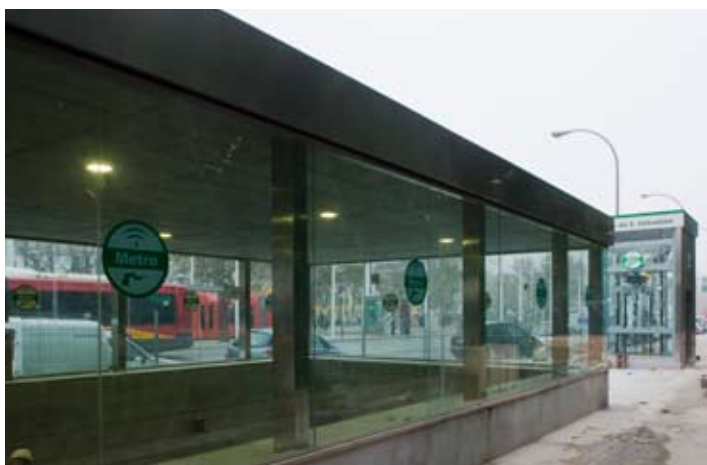
Volumen exterior de acero y cristal de la estación del Prado de San Sebastián.
