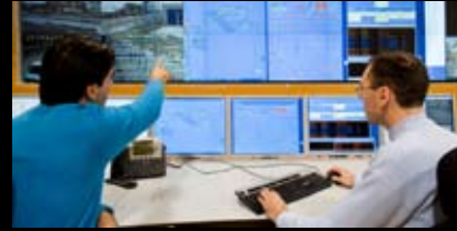
Centro de control durante las de pruebas de funcionamiento de las unidades móviles y los diversos sistemas del Metro.
