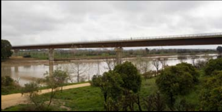
Nuevo puente para el Metro sobre el Guadalquivir a la altura de San Juan de Aznalfarache.
