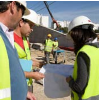
Trabajos de excavaciones.
