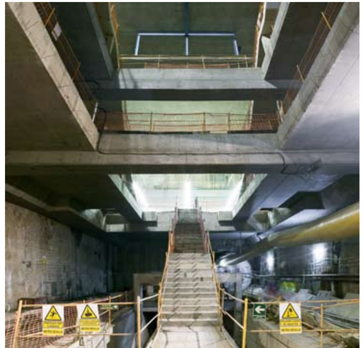
Estructuras de la estación de Plaza de Cuba.
