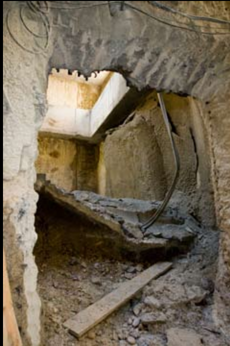
Secuencia de una operación de perforación: El muro empieza a acusar el empuje del escudo de la tuneladora, hasta ceder por completo.
