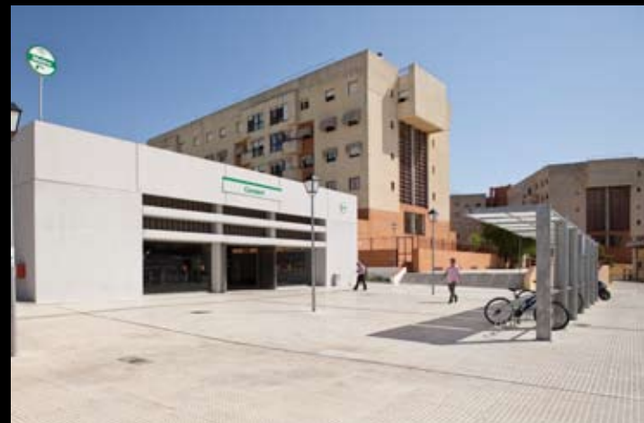
Estación de Metro de Sevilla, con aparcamiento de bicicletas.
