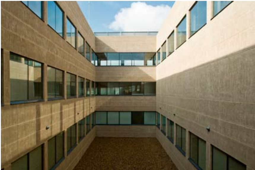
Edificio Corporativo de Metro de Sevilla.
