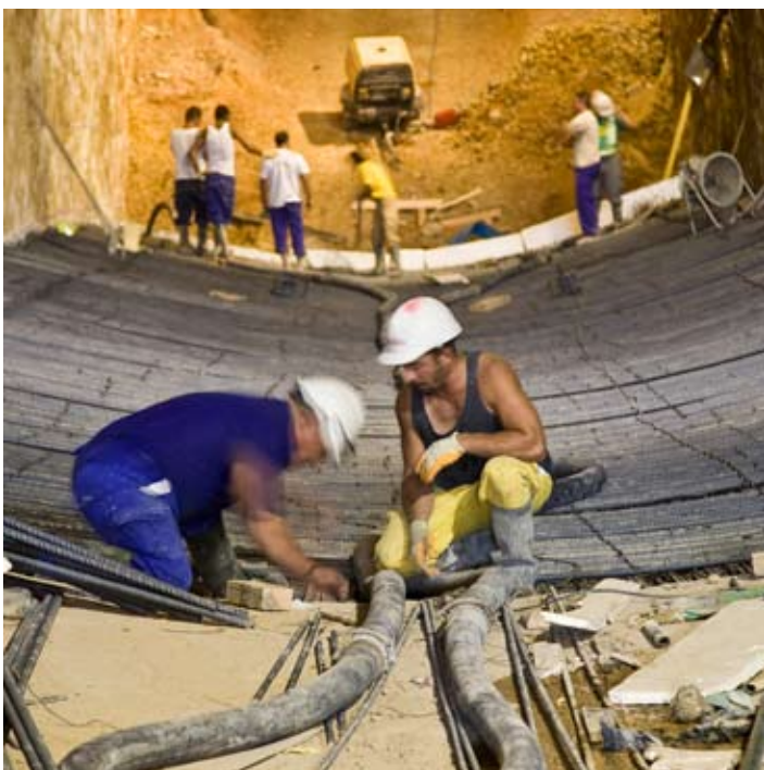
Obras en el último tramo de Montequinto.
