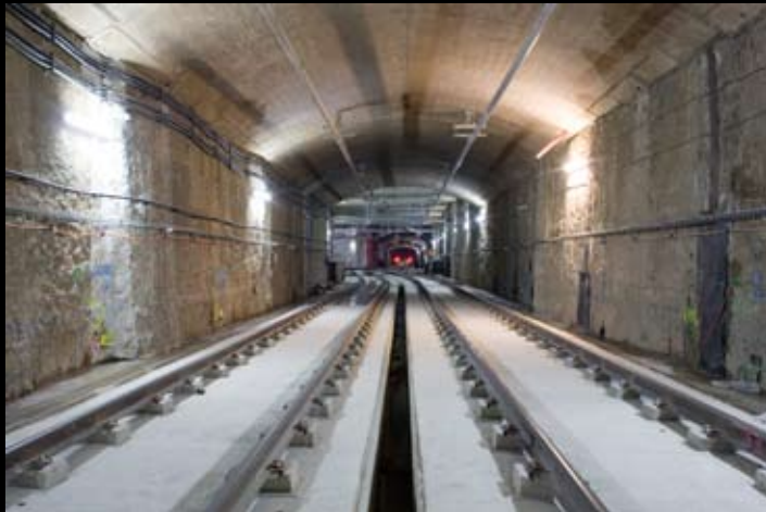
Antiguo túnel adaptado a las necesidades del metro actual, en el sector de Nervión.
