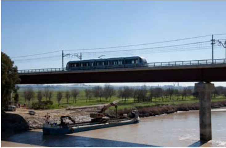
Imagen izquierda: Viaducto y puente sobre el Guadalquivir en San Juan de Aznalfarache.
