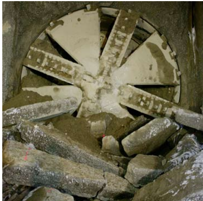
Escudo de la tuneladora en funcionamiento, empleada para horadar el subsuelo y la construcción simultánea de túneles.
