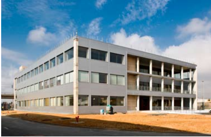
Imagen izquierda: Edificio corporativo para alojamiento del centro de control del Metro.
