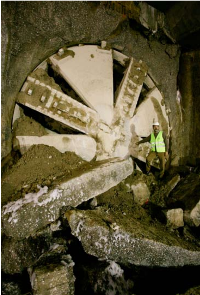
Avance de la tuneladora a lo largo de los túneles de la Línea 1 de Metro de Sevilla.
