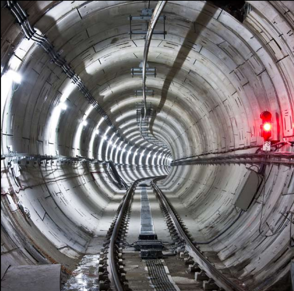
Túnel en el Tramo 1 de la Línea 1 de Metro de Sevilla.
