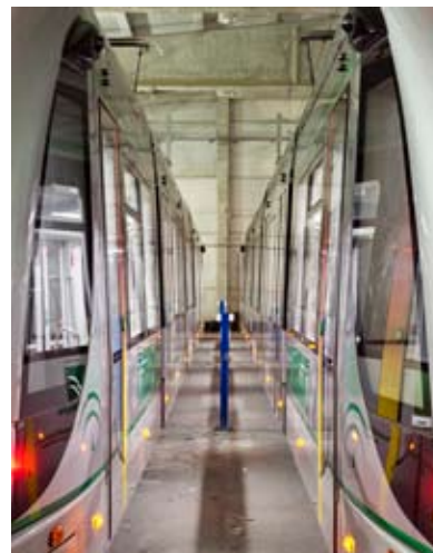
Unidades ferroviarias en la Nave de Cocheras y Talleres de Metro de Sevilla.
