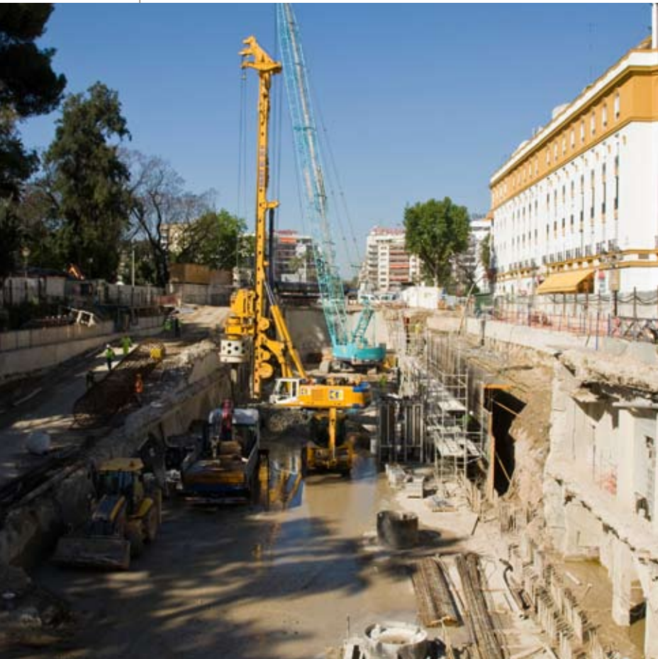
Construcción de la estación en la Puerta de Jerez.
