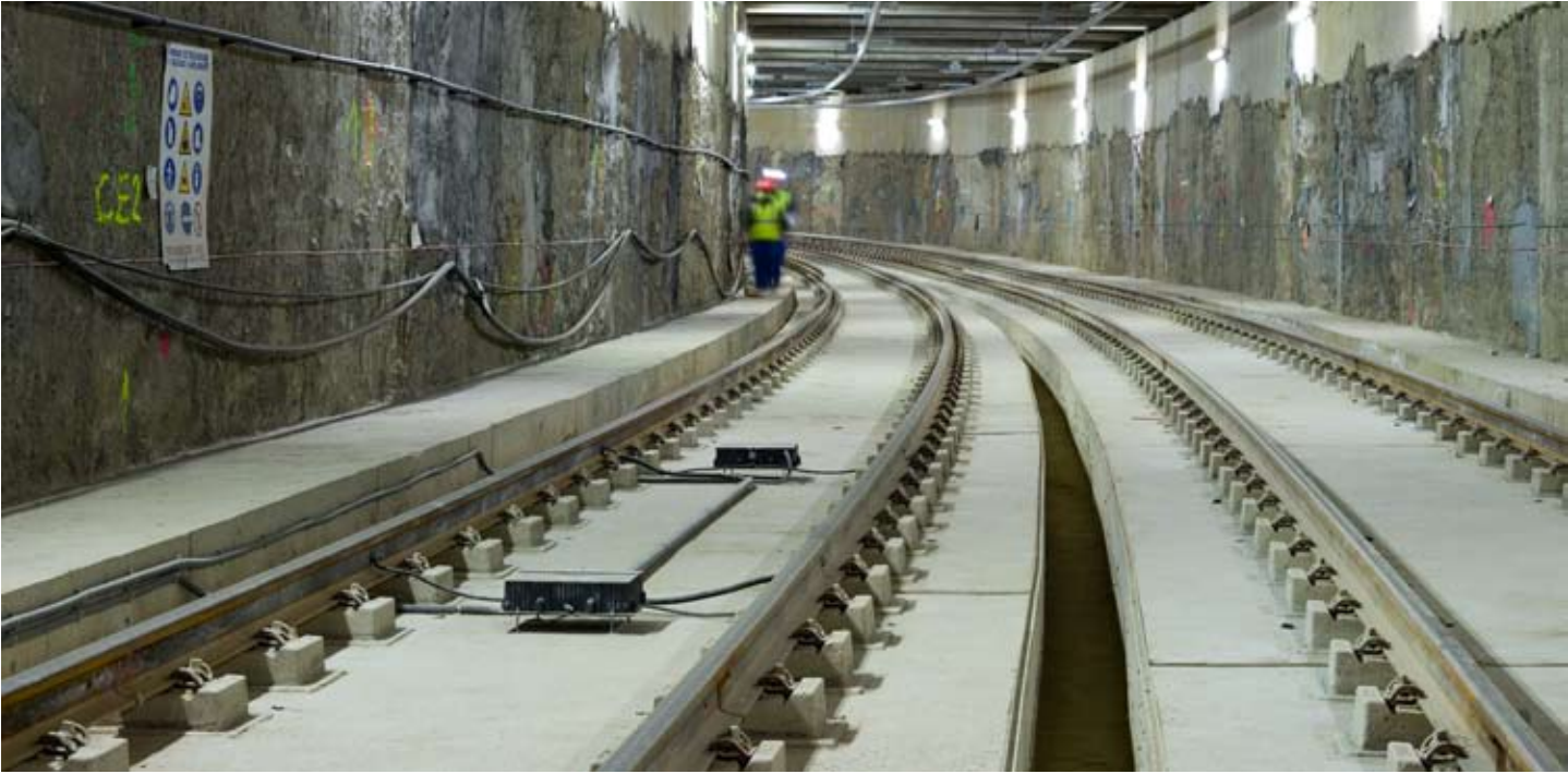
Túnel entre las estaciones de Ciudad Expo y Cavaleri.
