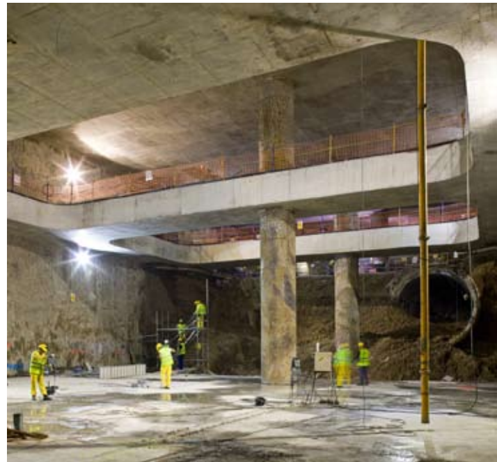
Trabajos de construcción en la estación de Puerta de Jerez.
