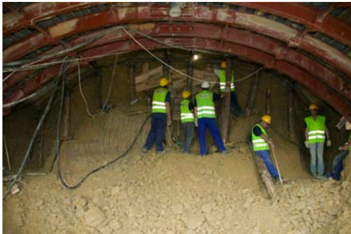
Excavación del túnel en mina en el trazado bajo el Monumento de San Juan de Aznalfarache.
