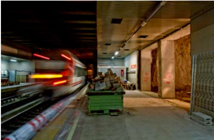
Túnel de conexión entre la estación de Metro de San Bernardo y la estación de RENFE.
