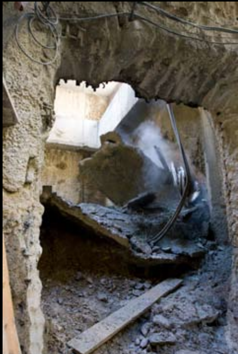
Secuencia de una operación de perforación: El muro empieza a acusar el empuje del escudo de la tuneladora, hasta ceder por completo.
