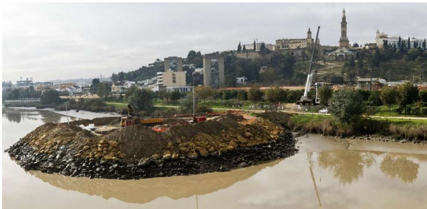
Inicios de los trabajos para el nuevo puente del Metro sobre el Guadalquivir en San Juan de Aznalfarache.
