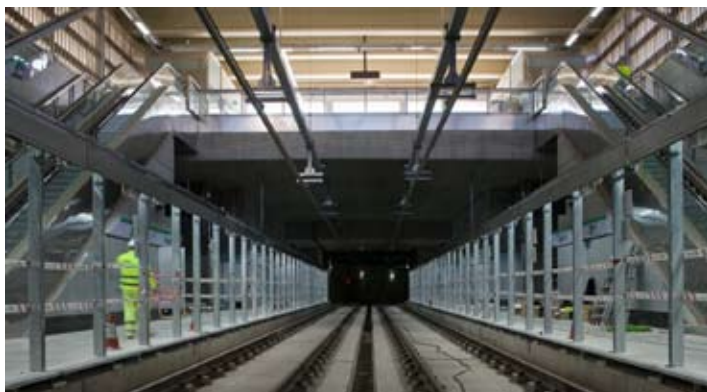
Interior de la estación de Cavaleri.
