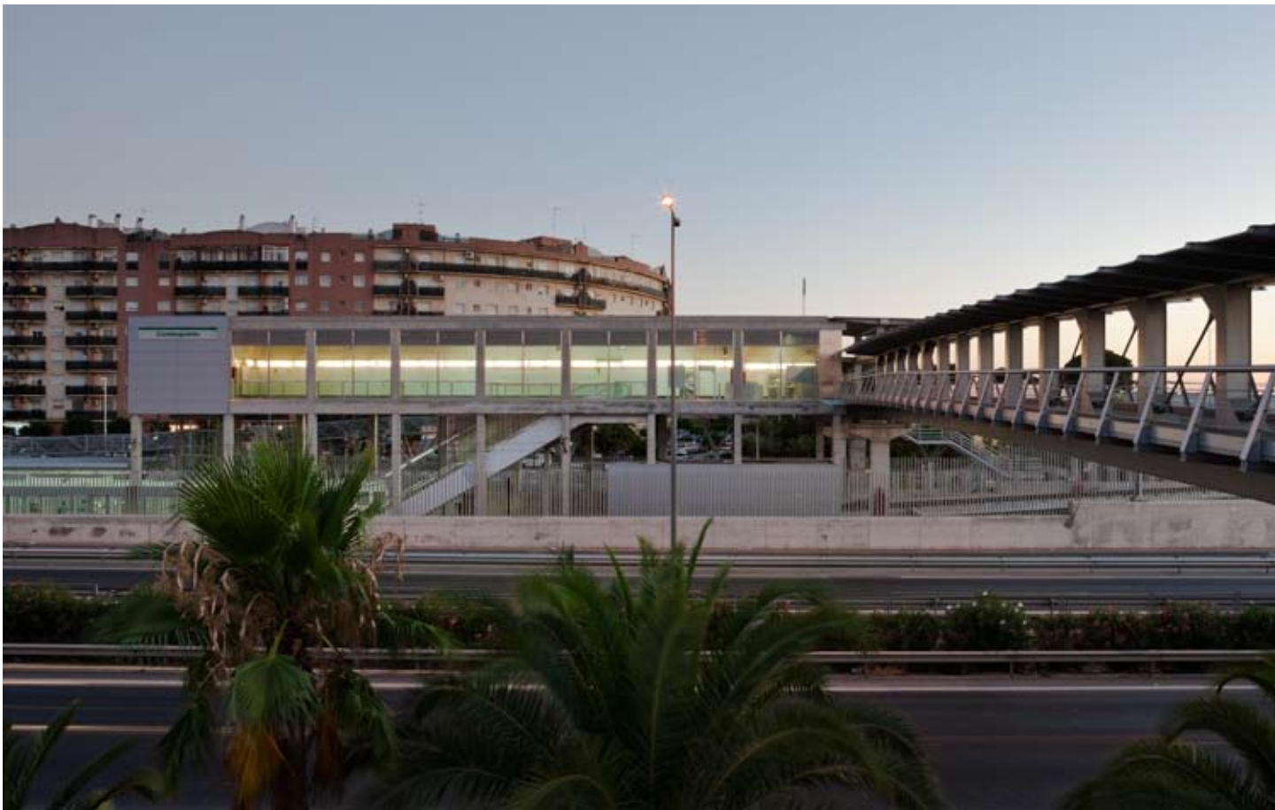
Estación de Condequinto.
