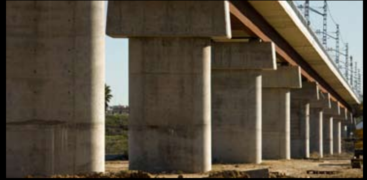
Viaducto entre San Juan de Aznalfarache y Sevilla.
