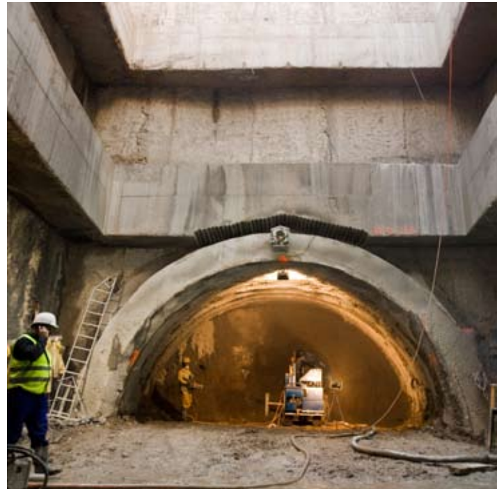
Excavación de túnel.
