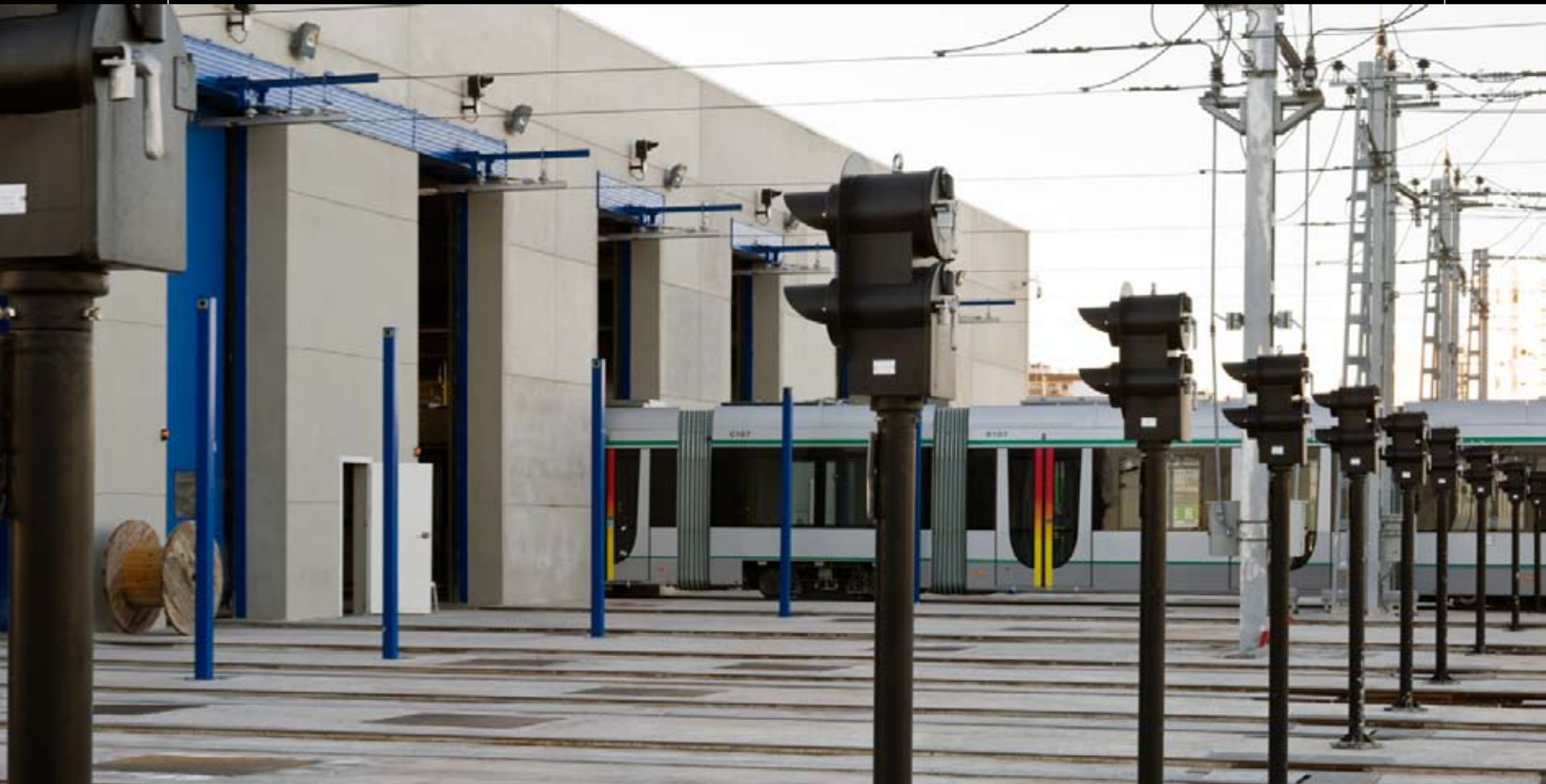
Playa de vías y Nave de Talleres y Cocheras en el Recinto Corporativo de Metro de Sevilla.
