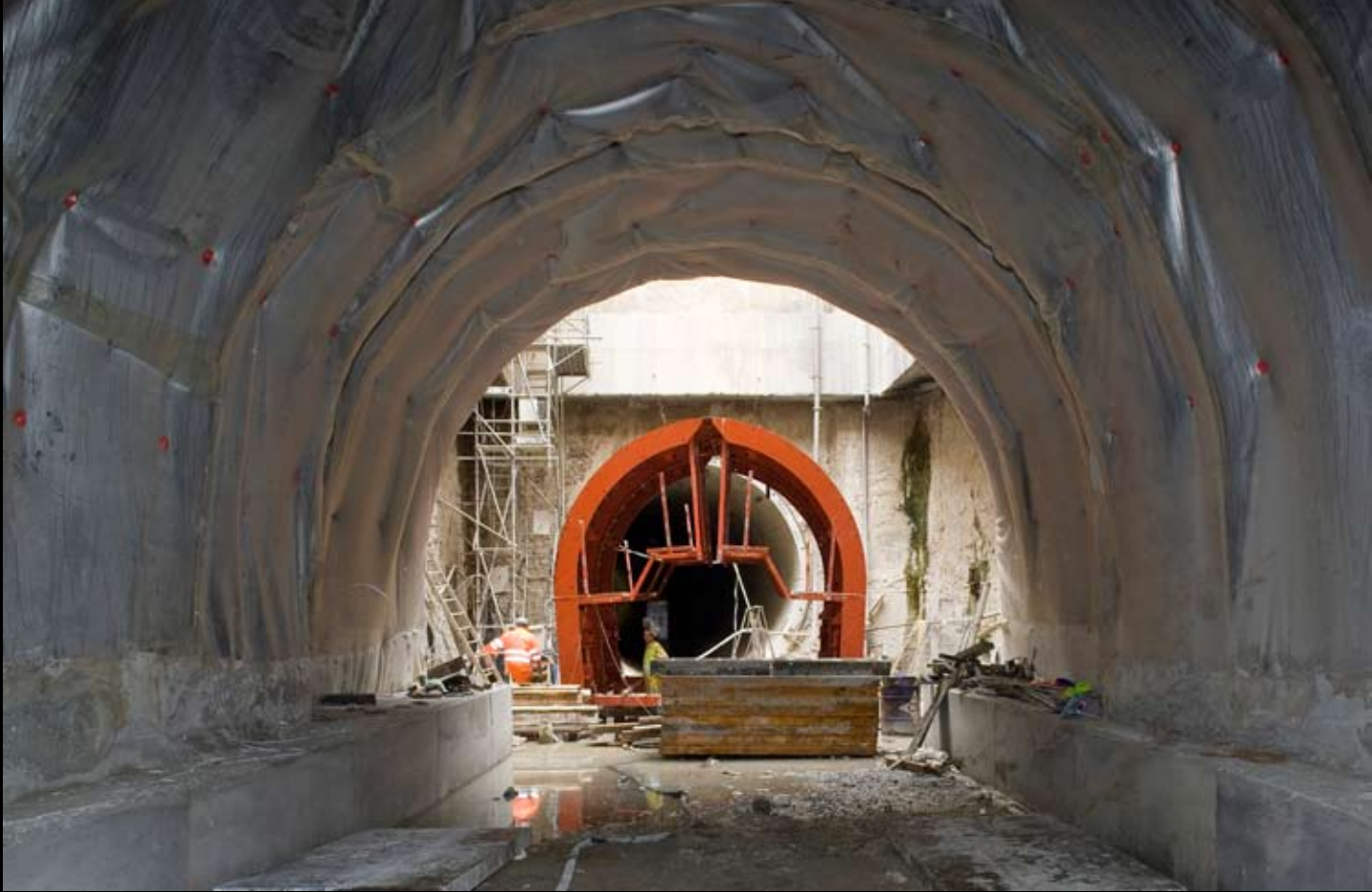
Túnel en mina de San Bernardo.
