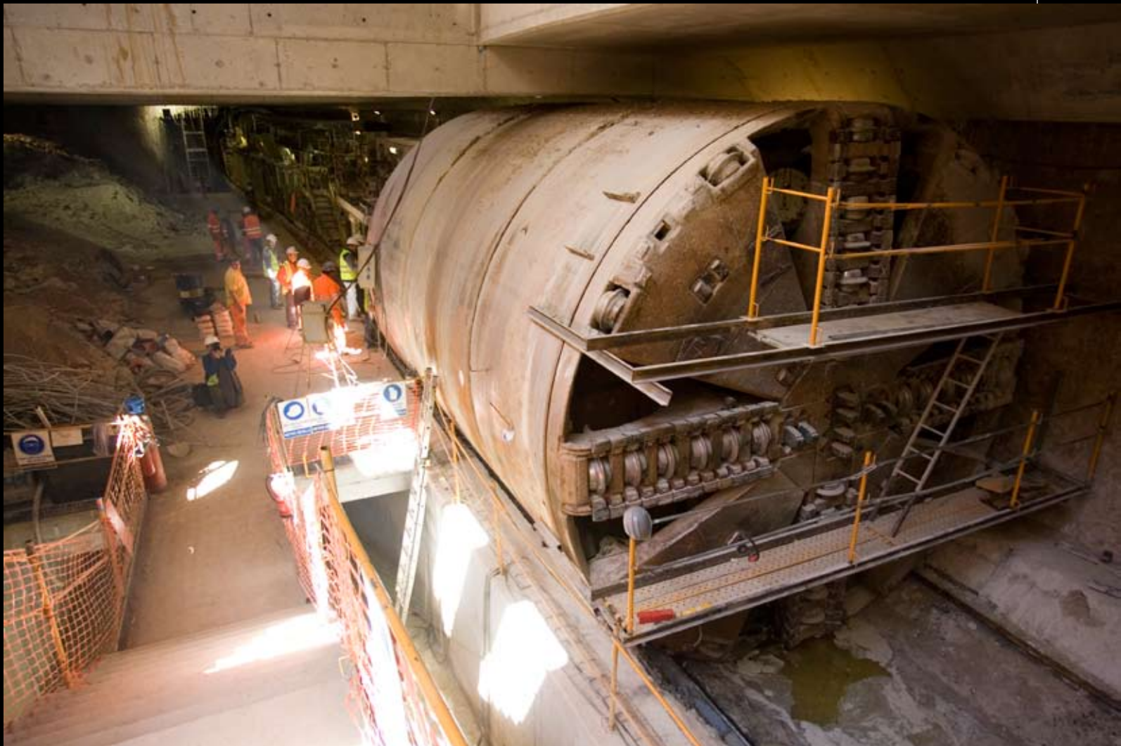
Una imagen frontal de la tuneladora, con el escudo en primer término.
