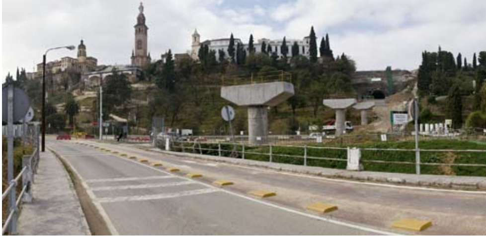
Estructuras de paso elevado y túnel bajo el Monumento de San Juan de Aznalfarache.
