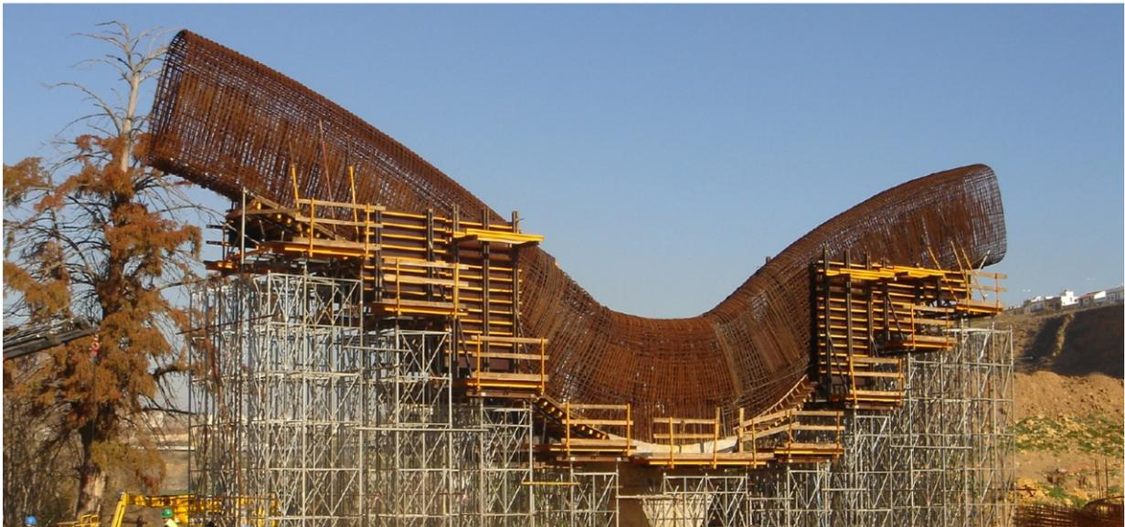
Ferralla de un arco bajo tablero junto con la cimbra y parte del encofrado
