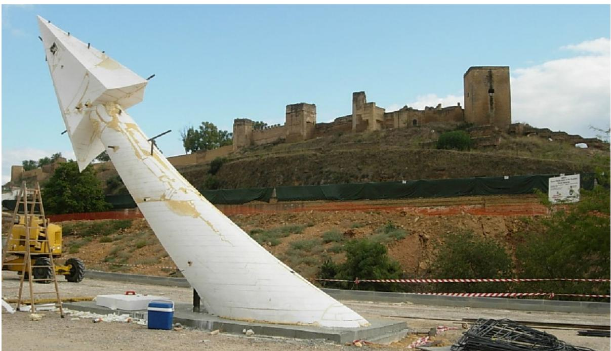
Fotografía 5. Molde interior en porexpan de la cola
