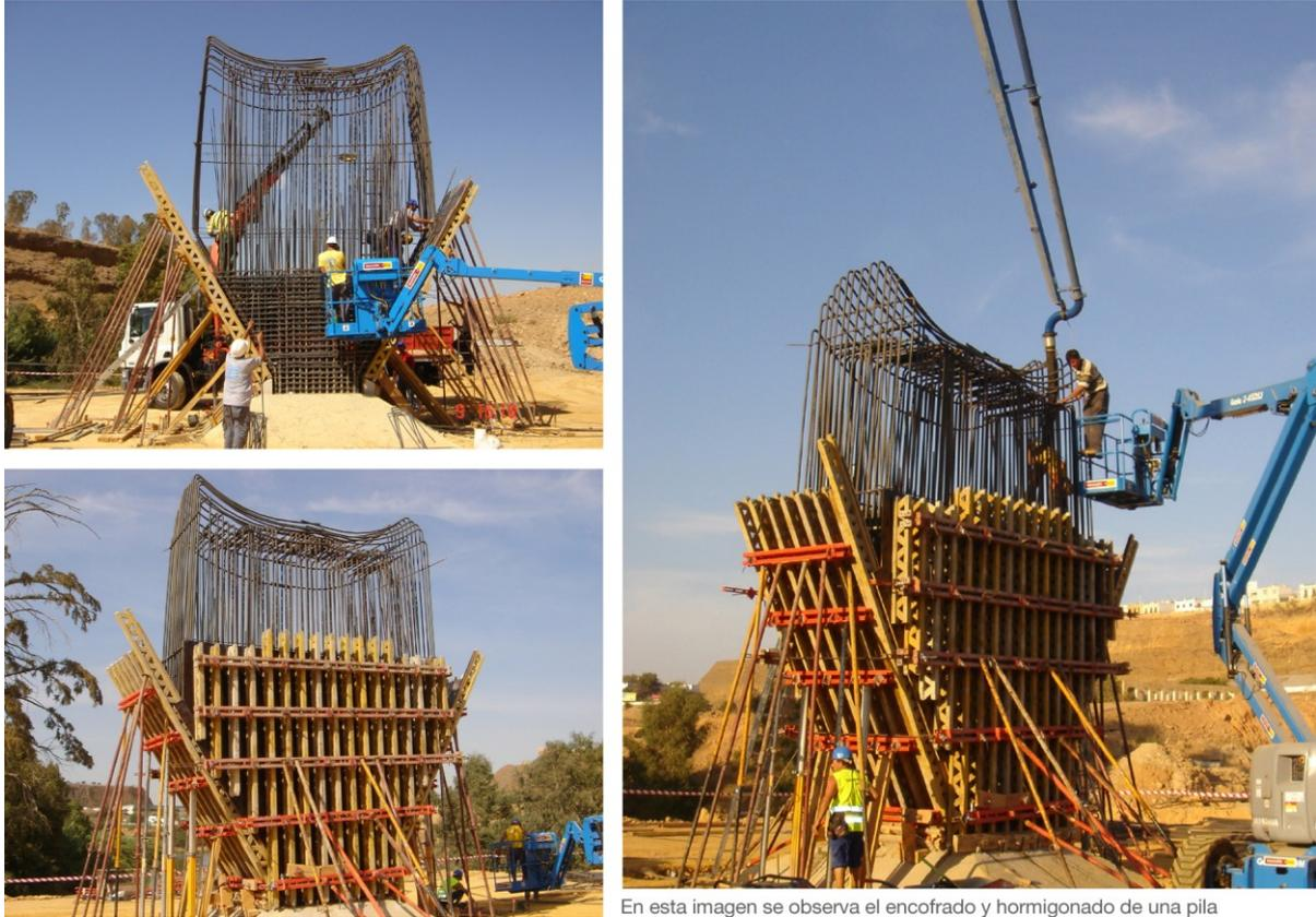
Todas estas anteriores fases se han ejecutado con material de encofrado diseñado y montado en obra expresamente para esta obra, de la empresa de encofrados PERI.
