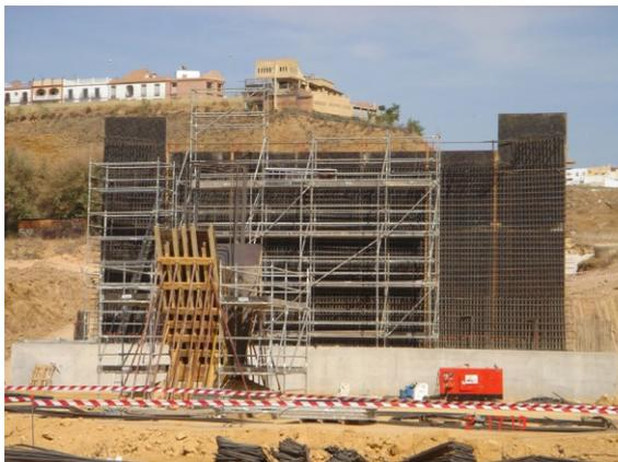
En esta fotografía se observan las armaduras del estribo 1 y los andamios requeridos para su colocación
