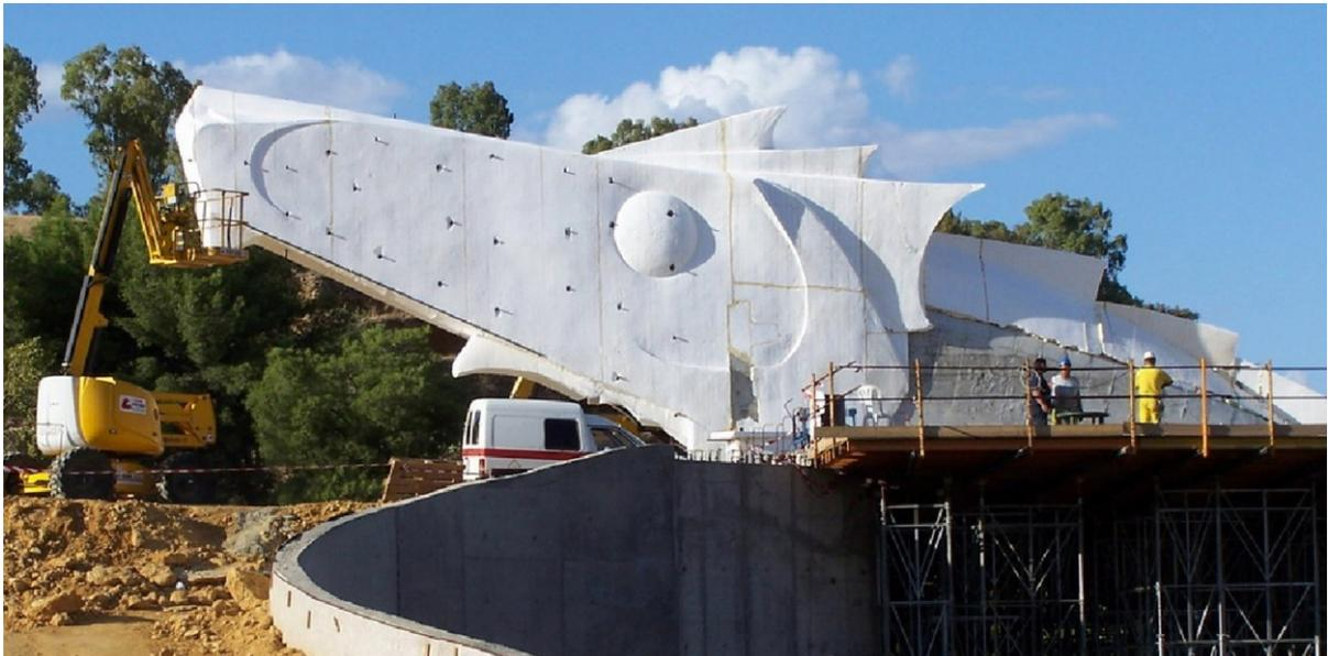
Fotografía 4. Molde interior en porexpan de la cabeza
