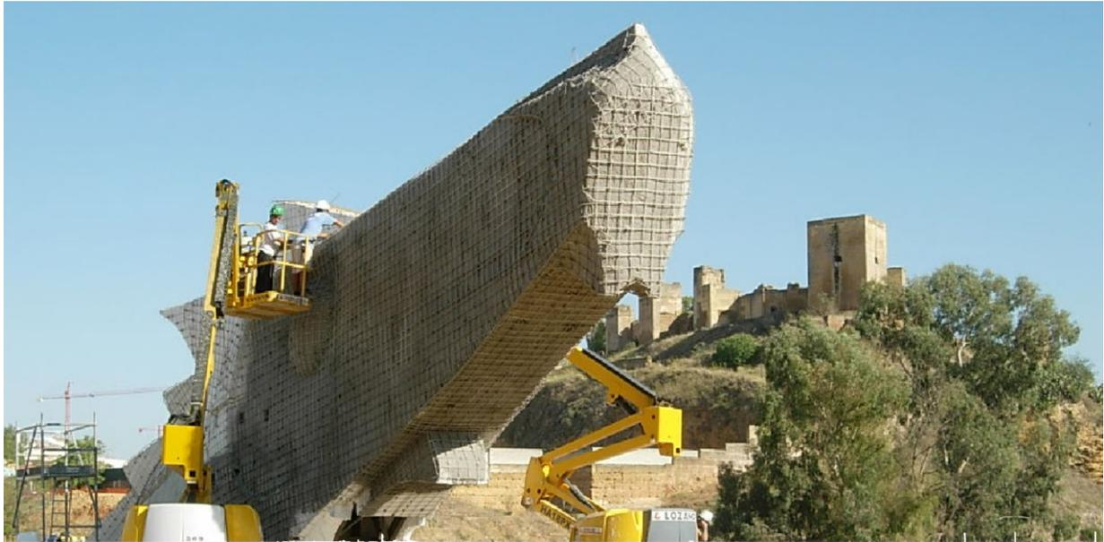
Apoyándose en los latiguillos que habían servido de soporte a las piezas de porexpan, se acopló recubriendo como una piel ambas esculturas, un mallazo de acero corrugado. Sobre él se procedió a la extensión de una capa de gunita de 6 cm. de espesor
