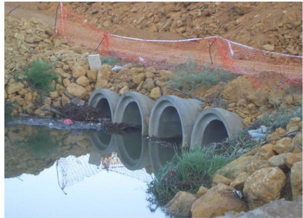
Tubos de hormigón armado de diámetro 1200 mm bajo el terraplenado de escollera y albero.
