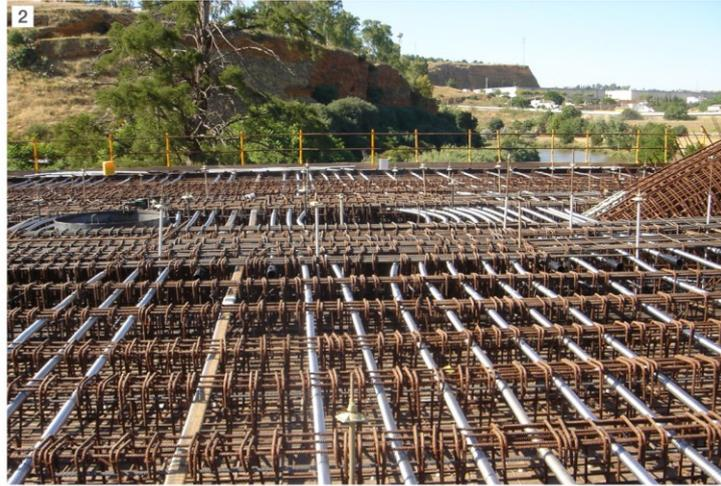
1. 2. 3. Disposición de las vainas del postensado entre la gran densidad de armaduras.
