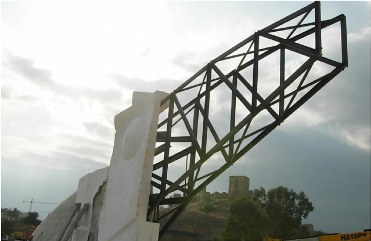
Fotografía 3. Estructura metálica interna de soporte de la cabeza
