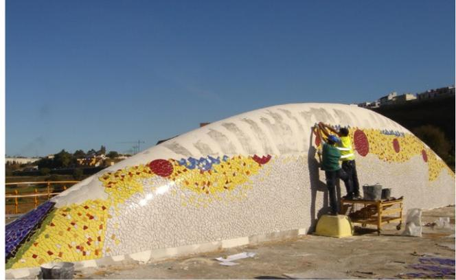
La colocación de las mallas no se realiza al azar, sino que previamente se ha diseñado en el ordenador y se sigue una numeración
