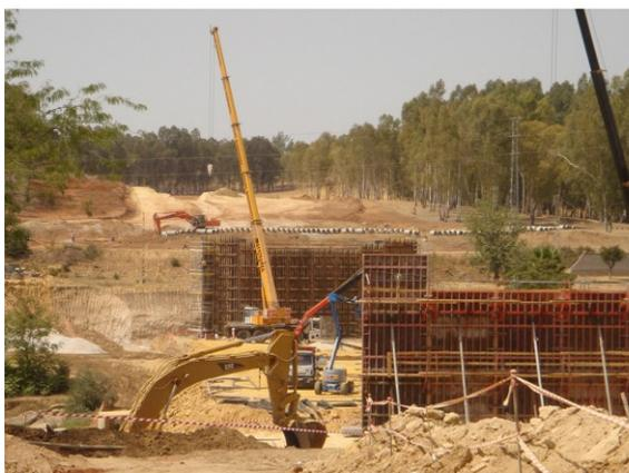
Vista de los encofrados de ambos estribos
