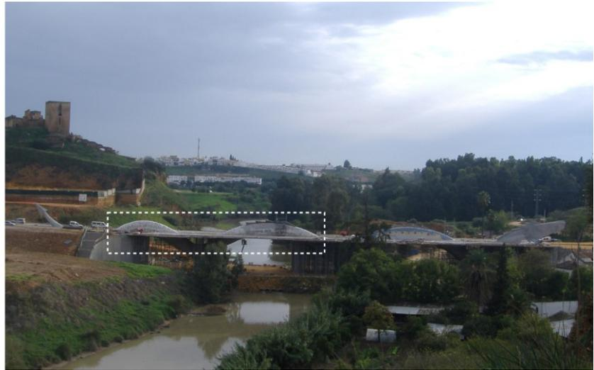
Lomo sobre las pilas 1 y 2 y sobre estribo 1 ya hormigonado
