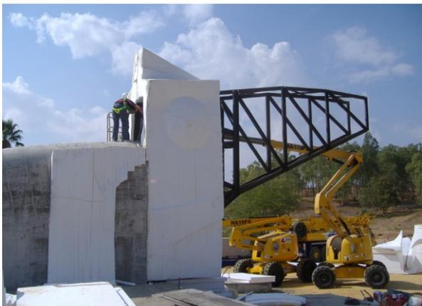
En esta fotografía se observa la estructura metálica de la cabeza junto con el porexpan
