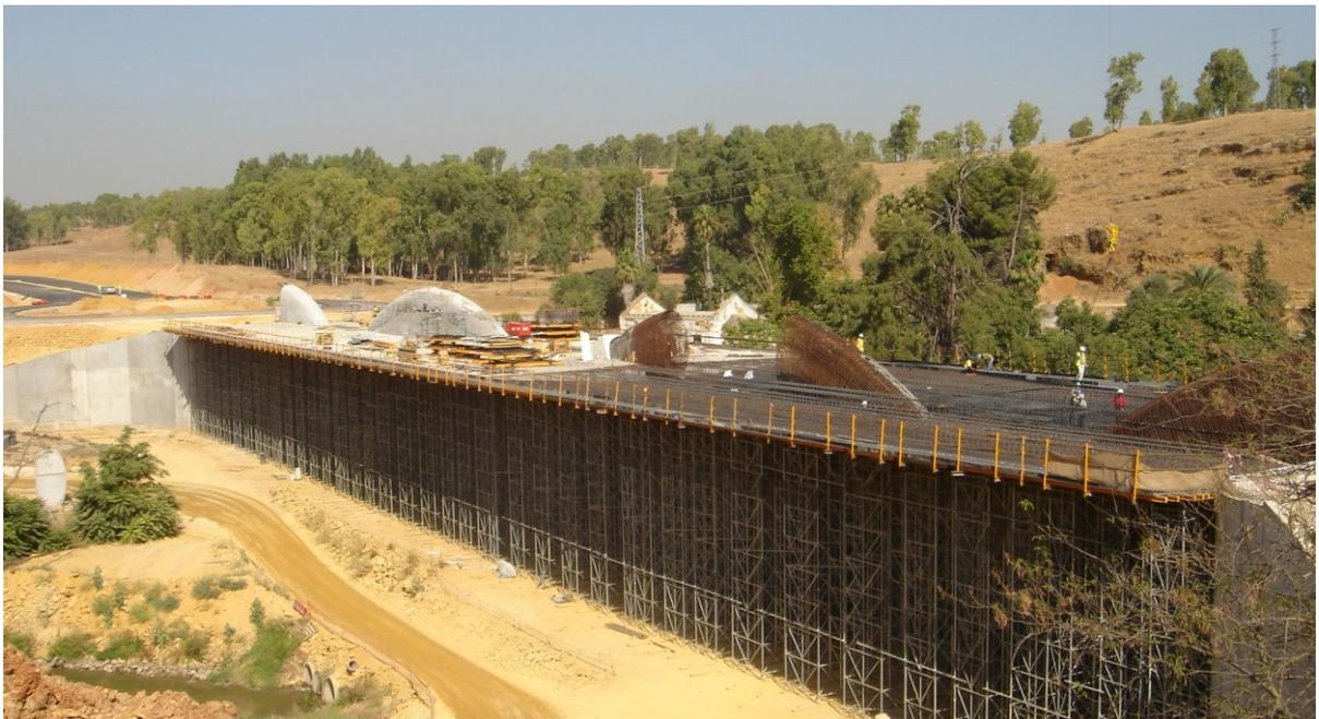
Ejecución del lomo sobre las pilas 1 y 2 y sobre estribo 1. Además puede observarse la enorme cimbra continua apoyada en el suelo
