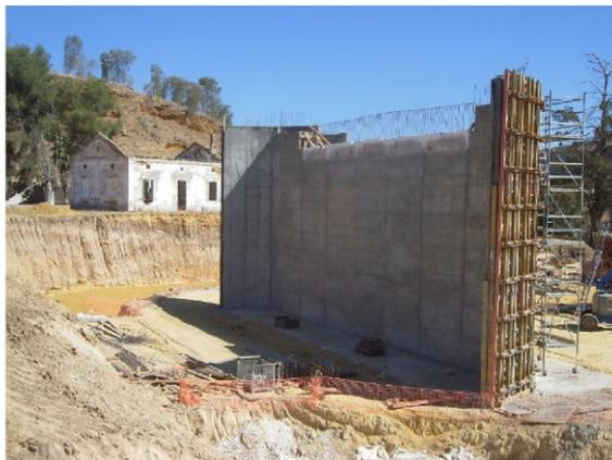
Estribo 2 ya hormigonado quedando aún parte del encofrado
