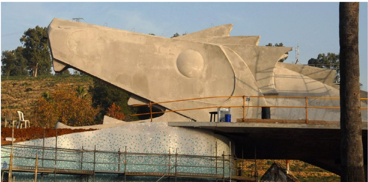
Fotografía 7. Cabeza terminada en hormigón
