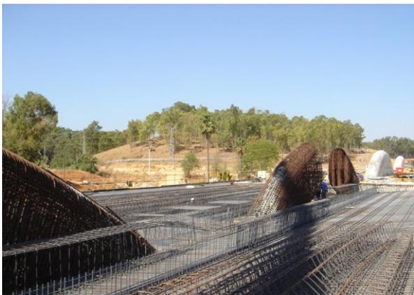
Se está armando el tablero entre estribo 1 y extremo del arco de la pila 2 a pila 1 (fase 2). Al fondo se observa el tablero y los lomos ya hormigonados en la fase anterior
