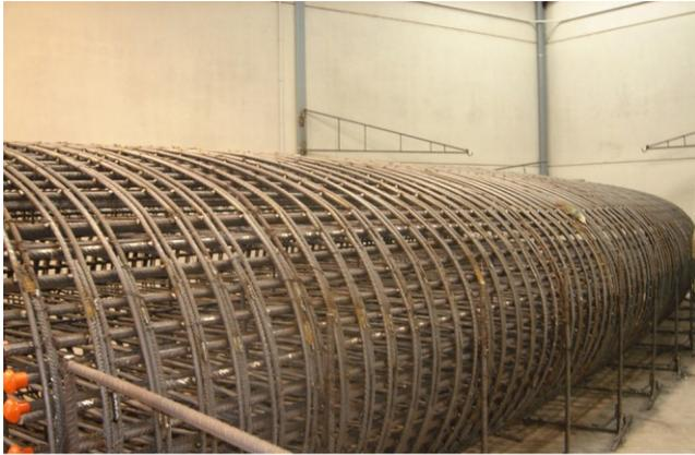
Armazón de acero del cuerpo ovoidal fabricado en taller para garantizar la geometría requerida
