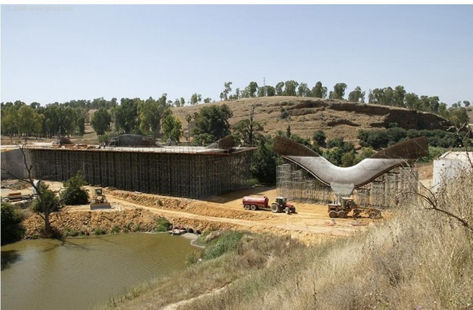
Fase 9. Ejecución del lomo (arco sobre tablero) entre las pilas 2 y 3, y el tramo de lomo sobre el estribo 2: Inicio a finales de junio de 2006 y finalización a mediados de agosto de 2006.
