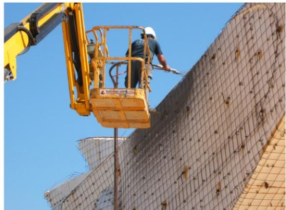
Se observa el mallazo exterior y gunitado de la cabeza del dragón con morteros especiales
