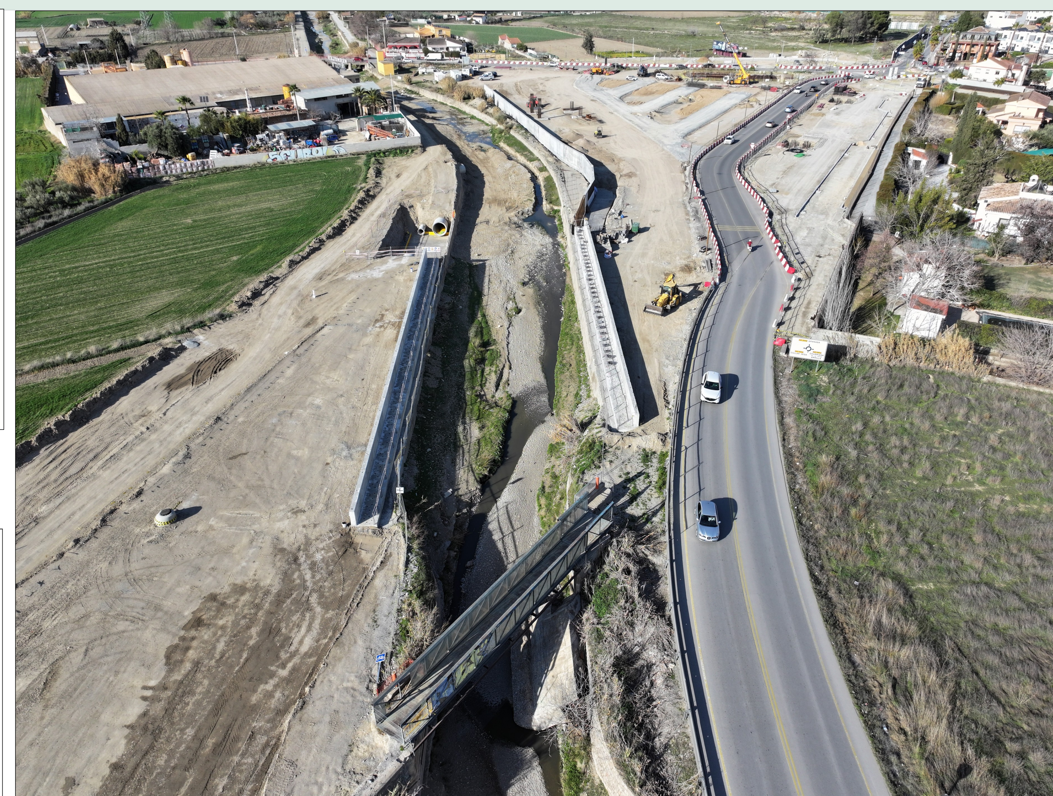
VISTA AÉREA OBRAS MARZO 2025
