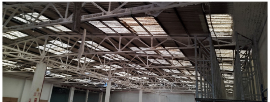
Interior de la nave y vista de la gran cantidad de paneles translúcidos instalados.
